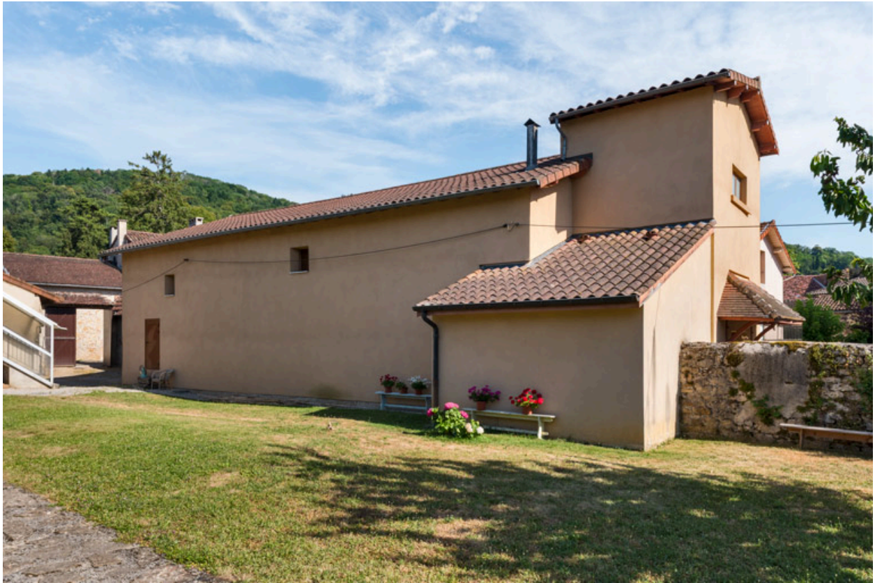
Façade latérale gauche, de trois quarts droite.
