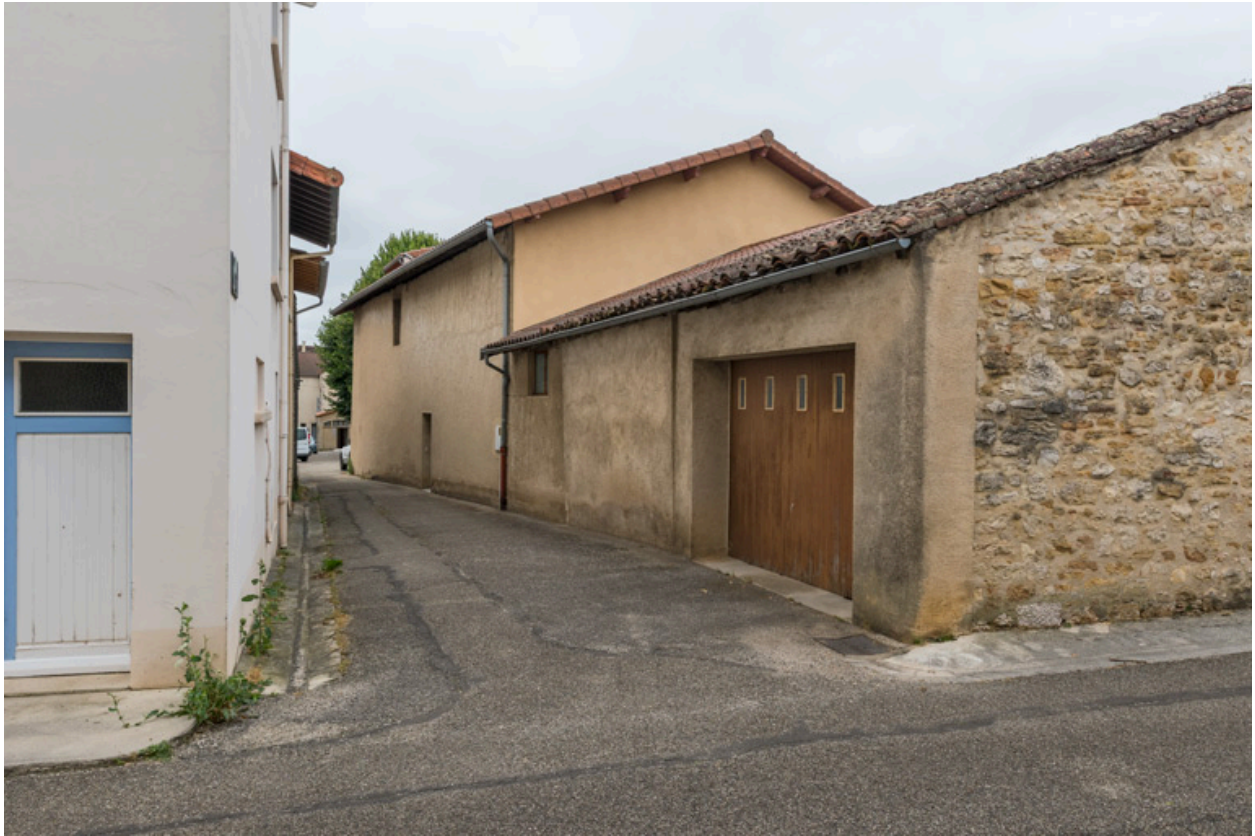
Façades postérieure et latérale droite.
