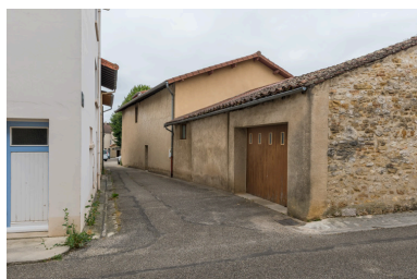
Façades postérieure et latérale droite. Phot. Pierre-Marie Barbe-Richaud IVR26_20257100416NUC4A
