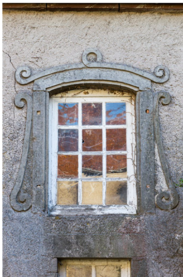
Détail d'une baie, façade ouest.
