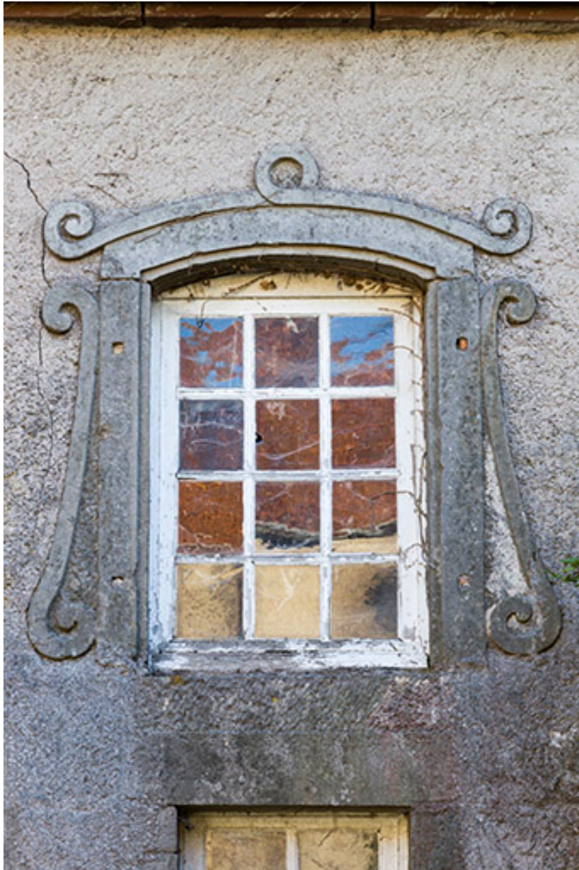
Détail d'une baie, façade ouest.
