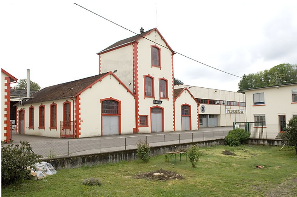
Bâtiments industriels. Vue de trois quarts gauche.
