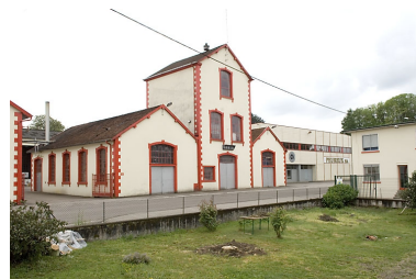
Bâtiments industriels. Vue de trois quarts gauche. Phot. Jérôme Mongreville IVR43_20077000115NUCA
