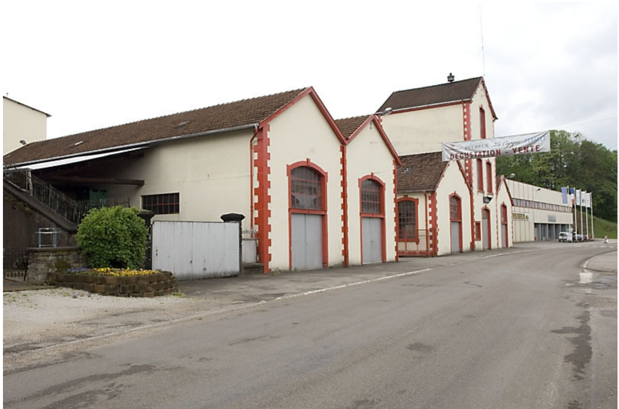
Bâtiments industriels. Vue depuis le nord-est.
