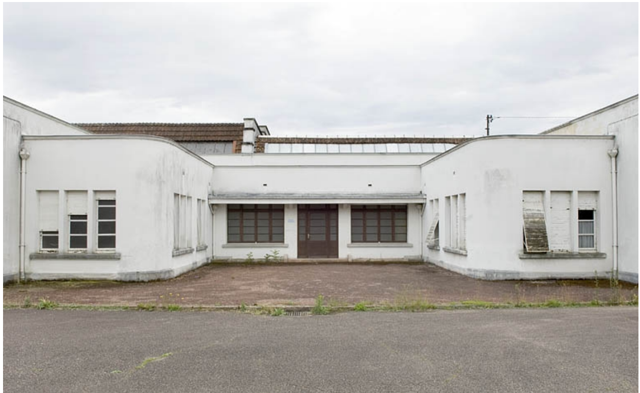
Les bureaux. Vue de face.
