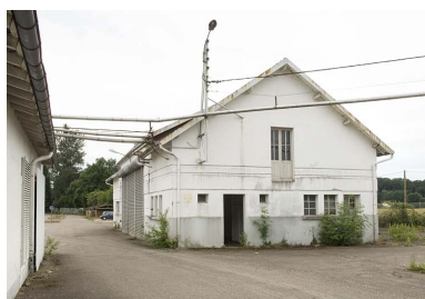
Garage à camions. Phot. Jérôme Mongreville IVR43_20097000395NUC2A
