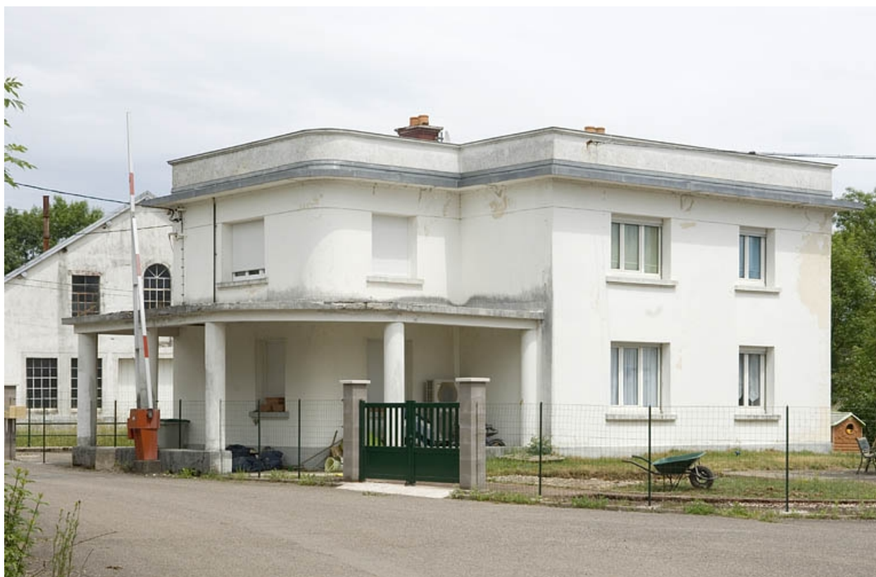
La conciergerie vue depuis la cour.
