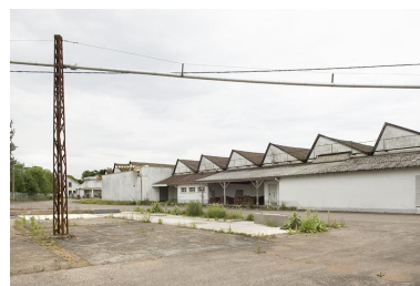
Atelier de fabrication depuis le sud-est.
