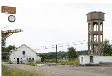
Garage à camions et château d'eau. Phot. Jérôme Mongreville IVR43_20097000389NUC2A
