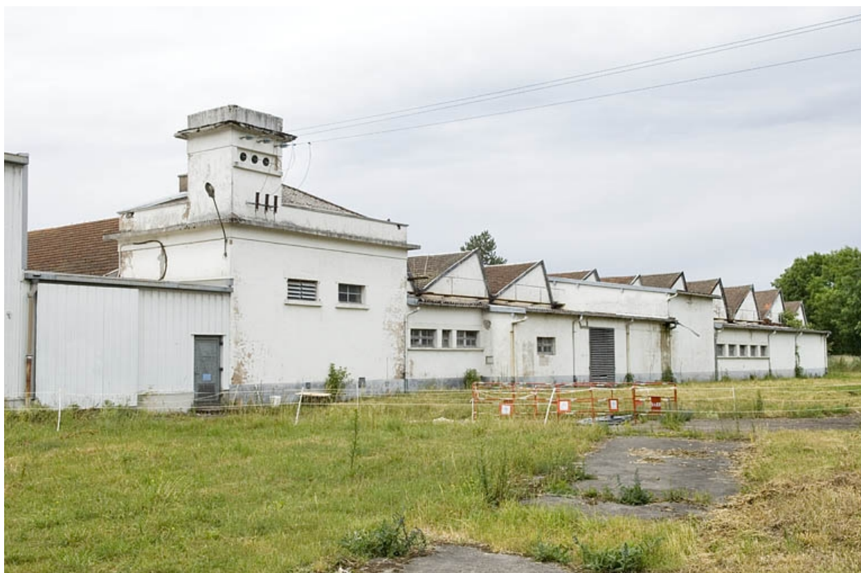
Façade est de l'atelier de fabrication.
