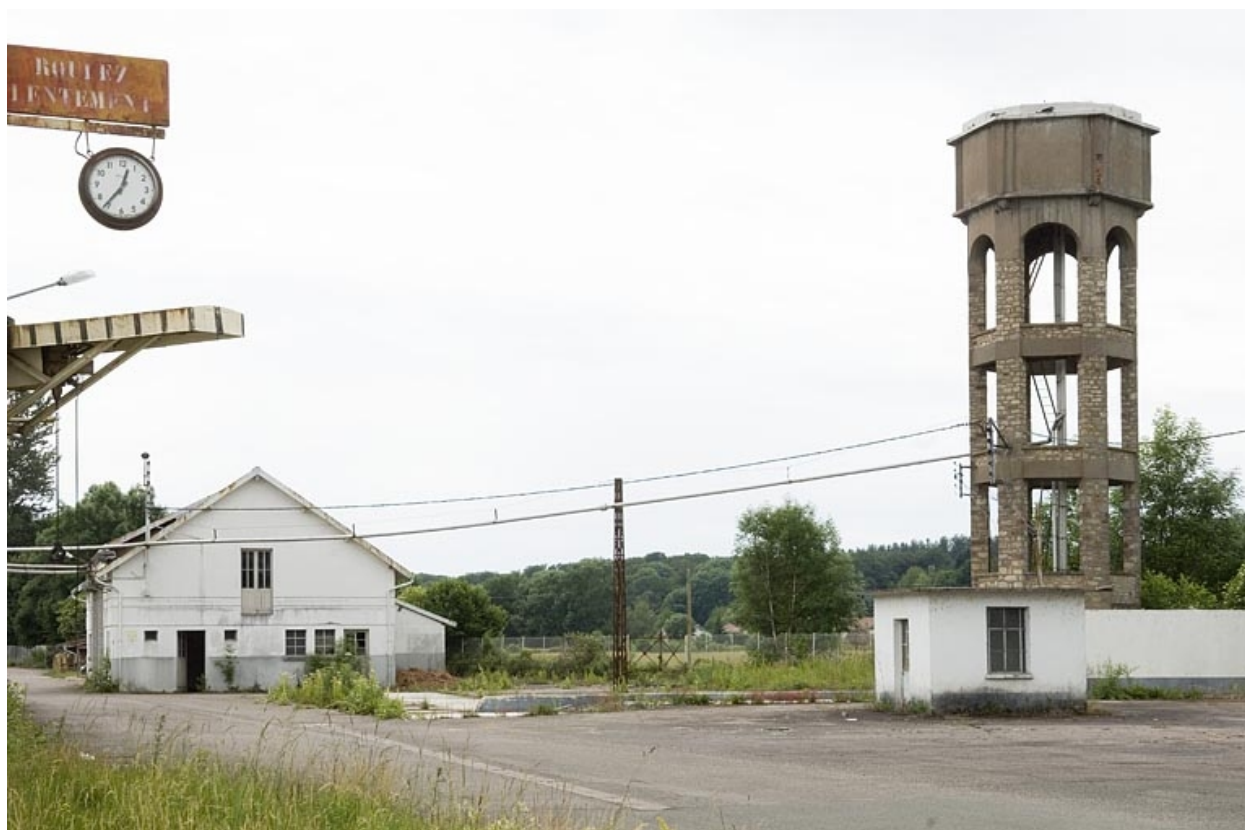
Garage à camions et château d'eau.
