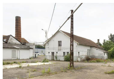
Cheminée et garage à camions.
