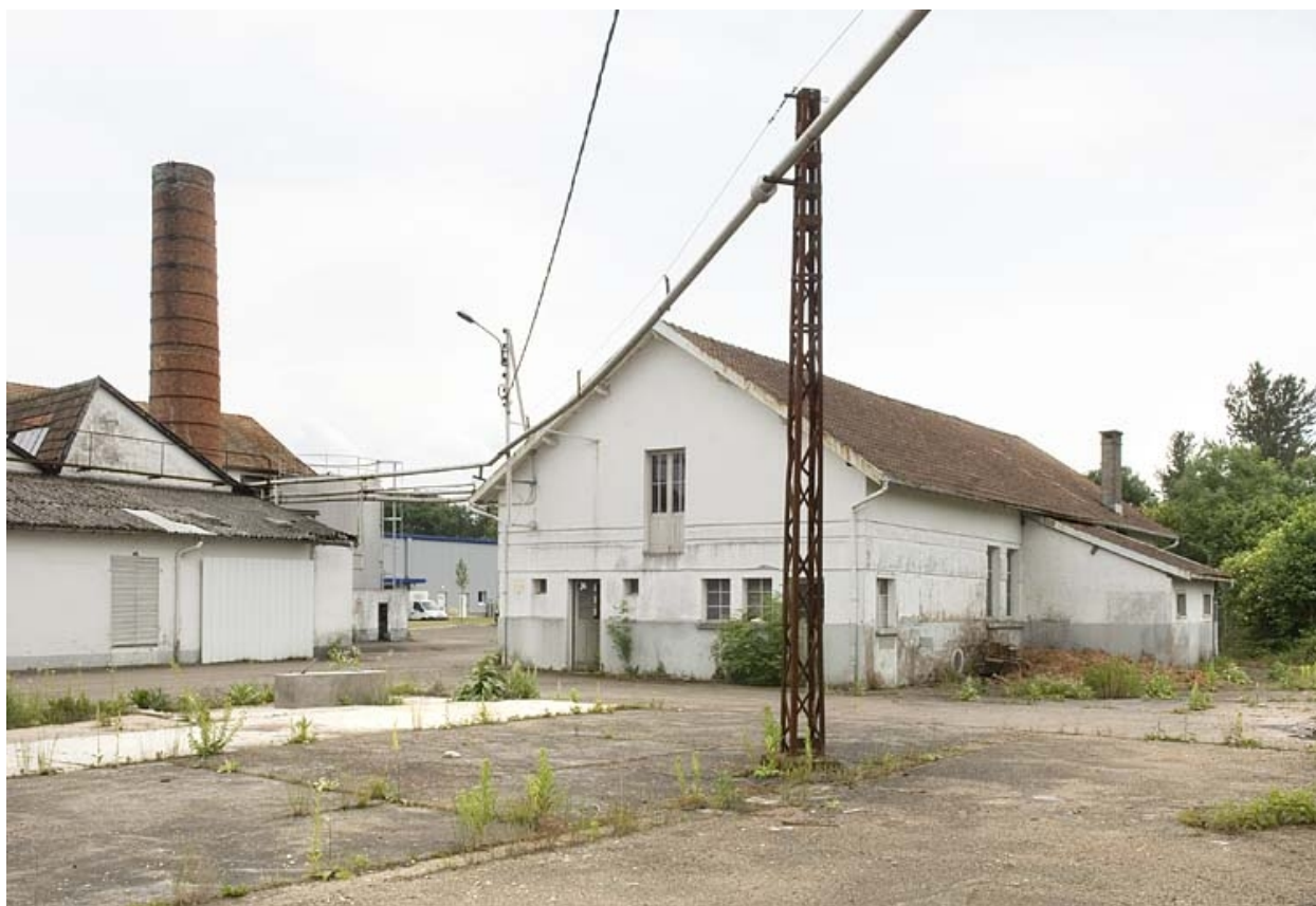
Cheminée et garage à camions.
