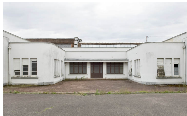
Les bureaux. Vue de face. Phot. Jérôme Mongreville IVR43_20097000401NUC2A
