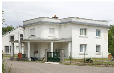
La conciergerie vue depuis la cour. Phot. Jérôme Mongreville IVR43_20097000400NUC2A
