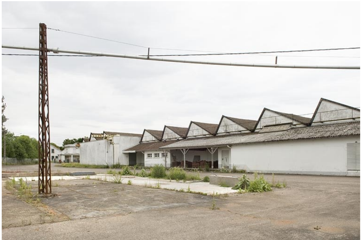
Atelier de fabrication depuis le sud-est.
