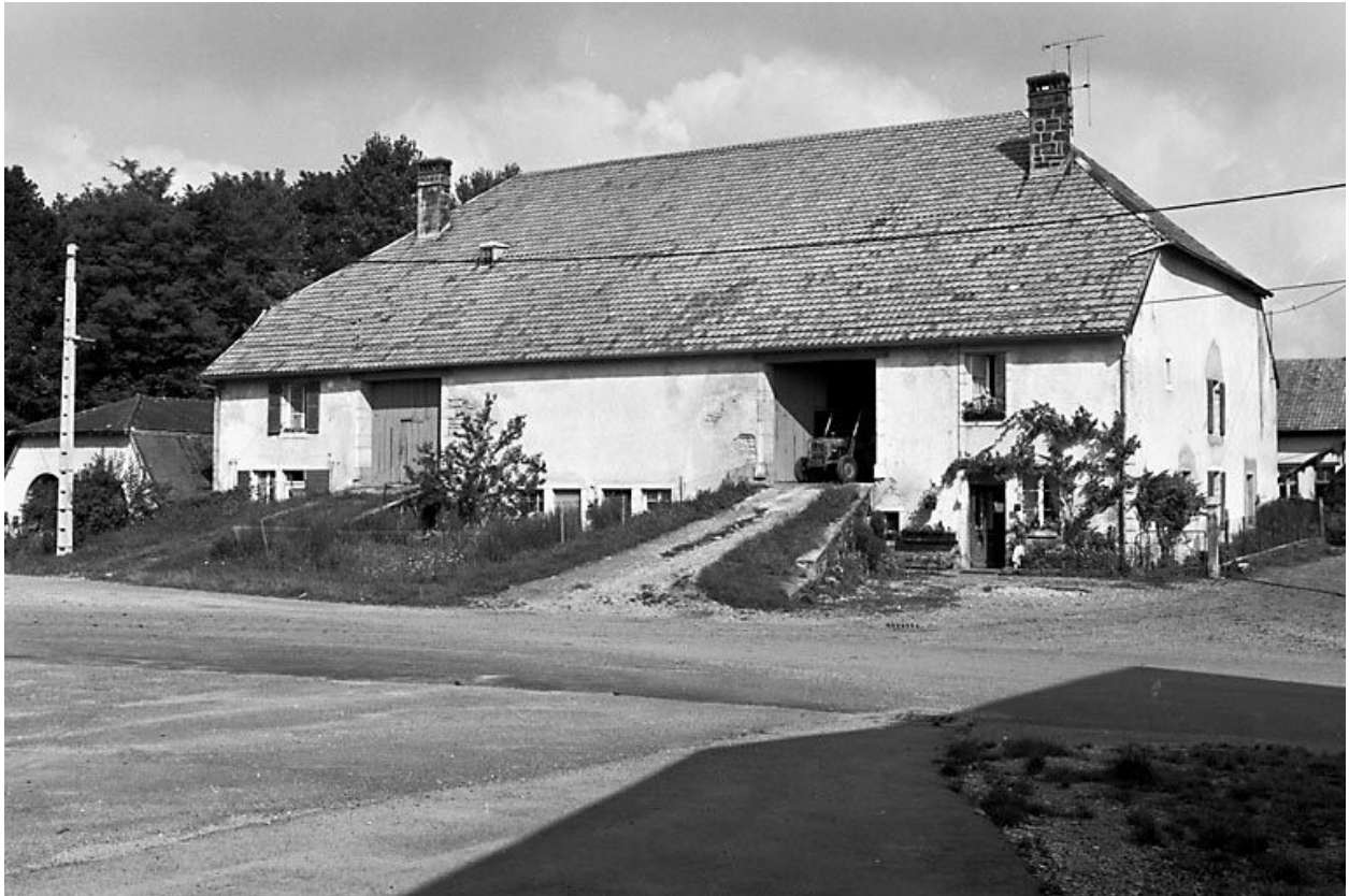
Façade antérieure et face latérale droite.
