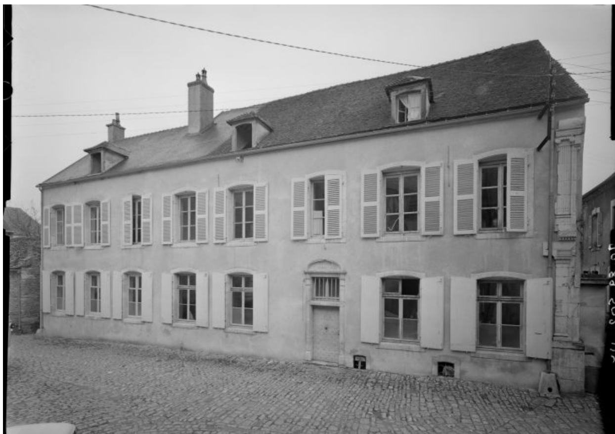
Façade sur la Petite Rue.
