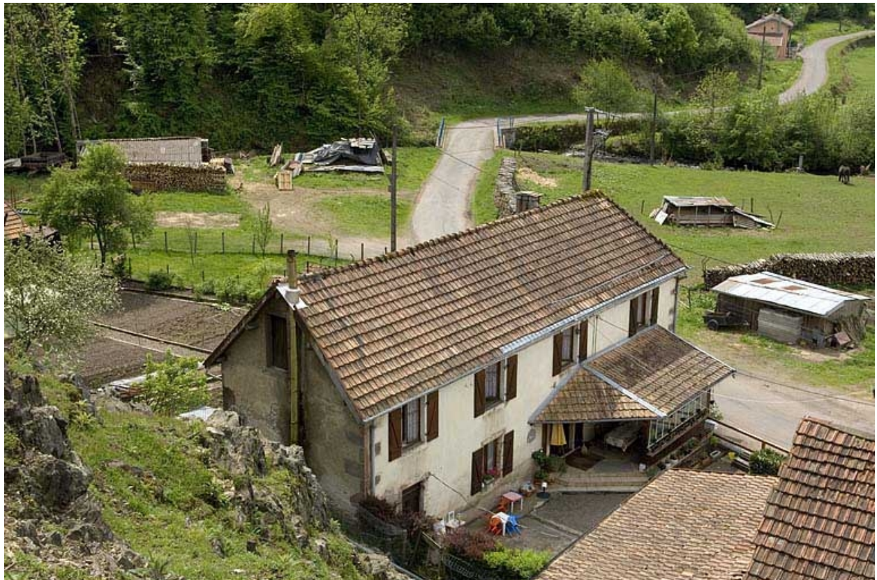
Vue plongeante sur un logement ouvrier.
