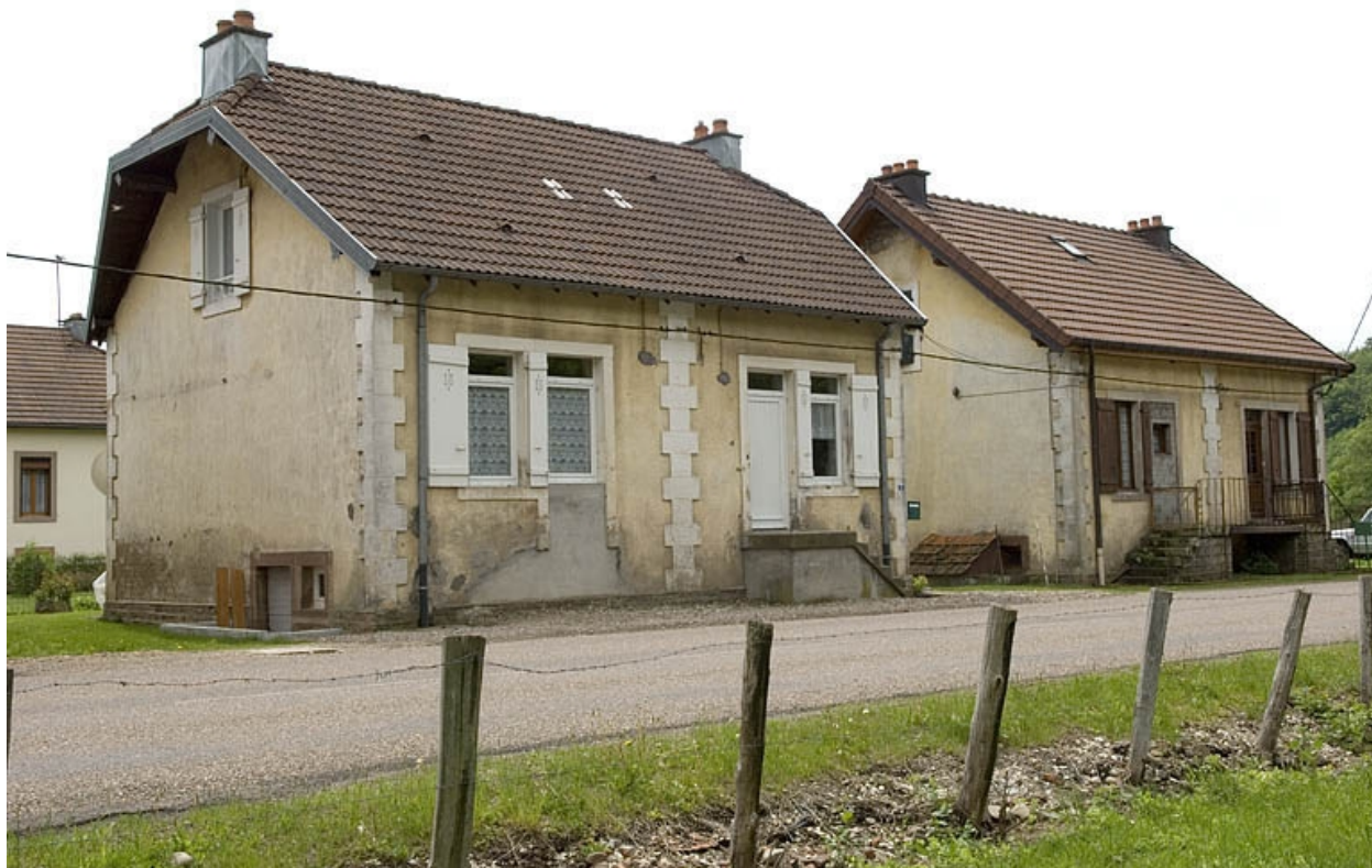
Deux logements doubles de la cité ouvrière.
