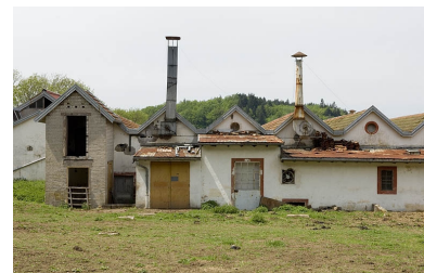
Pignons est de l'atelier de fabrication. Phot. Jérôme Mongreville IVR43_20067000376NUCA
