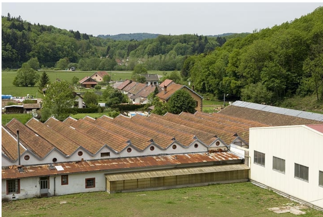
Vue plongeante depuis l'est. Extrémité nord.
