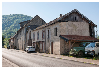
Vue d'ensemble depuis la route. Phot. Jérôme Mongreville IVR43_20152501291NUC4A
