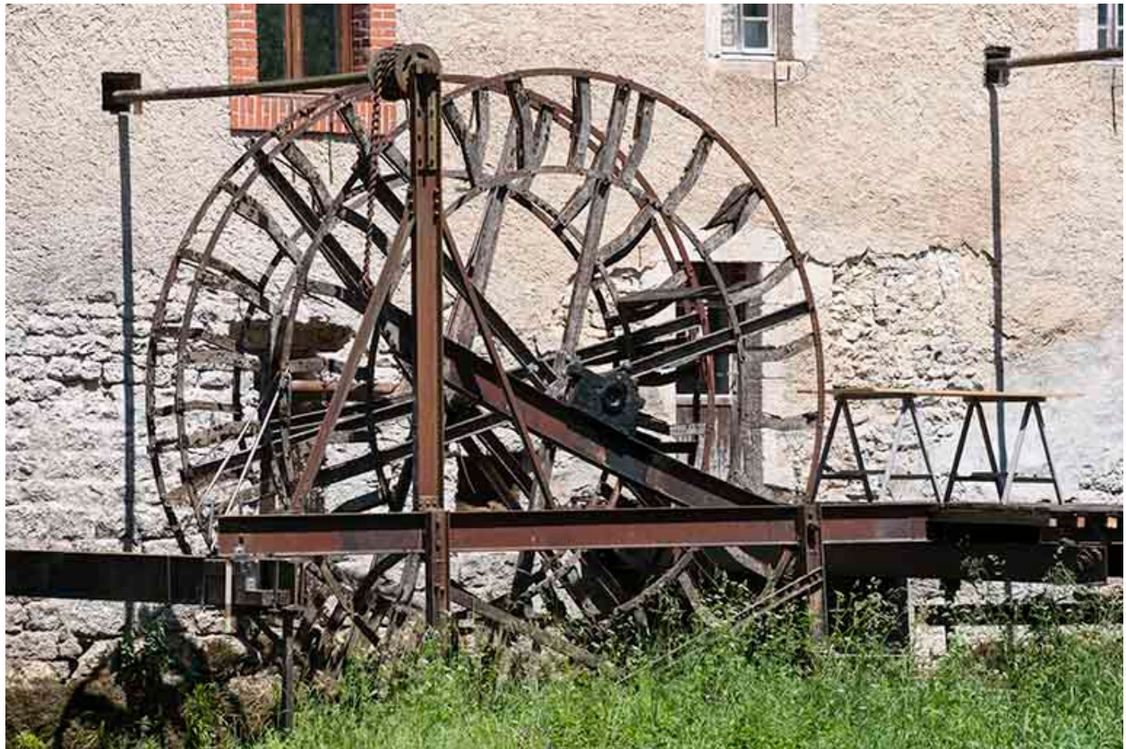
Roue hydraulique aval depuis la rive droite.
