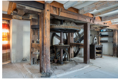
Rez-de-chaussée : beffroi (ouest) des meules. Phot. Jérôme Mongreville IVR43_20162501616NUC4A
