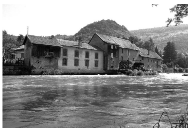
Vue depuis la rive gauche en aval en 1980. Phot. Yves Sancey IVR43_19802500400Z
