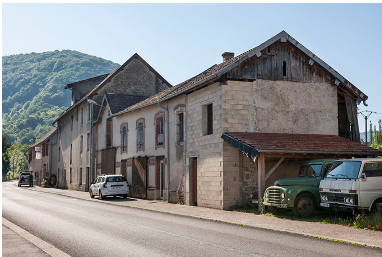
Vue d'ensemble depuis la route.
