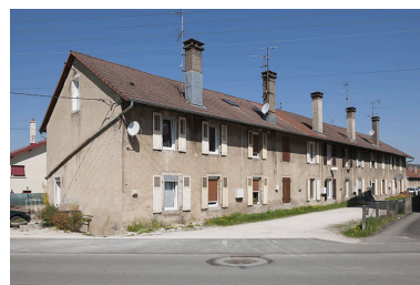
Habitation de type caserne. Phot. Jérôme Mongreville IVR43_20132500247NUC4A
