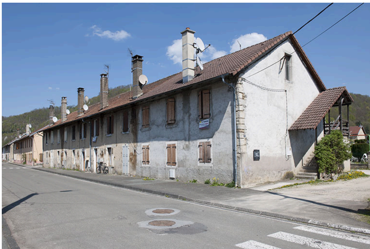
Alignement des façades des casernes (côté impair).
