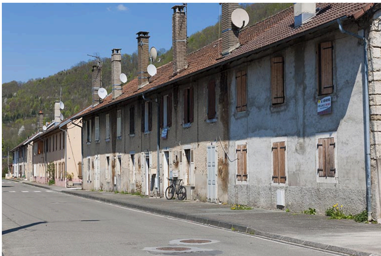
Habitations de type caserne (côté impair).
