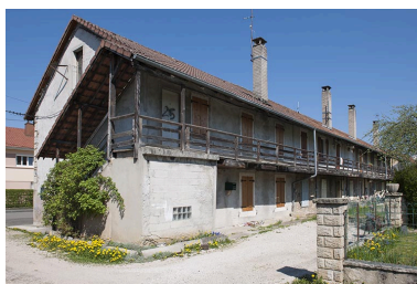
Façade postérieure d'une caserne. Phot. Jérôme Mongreville IVR43_20132500250NUC4A
