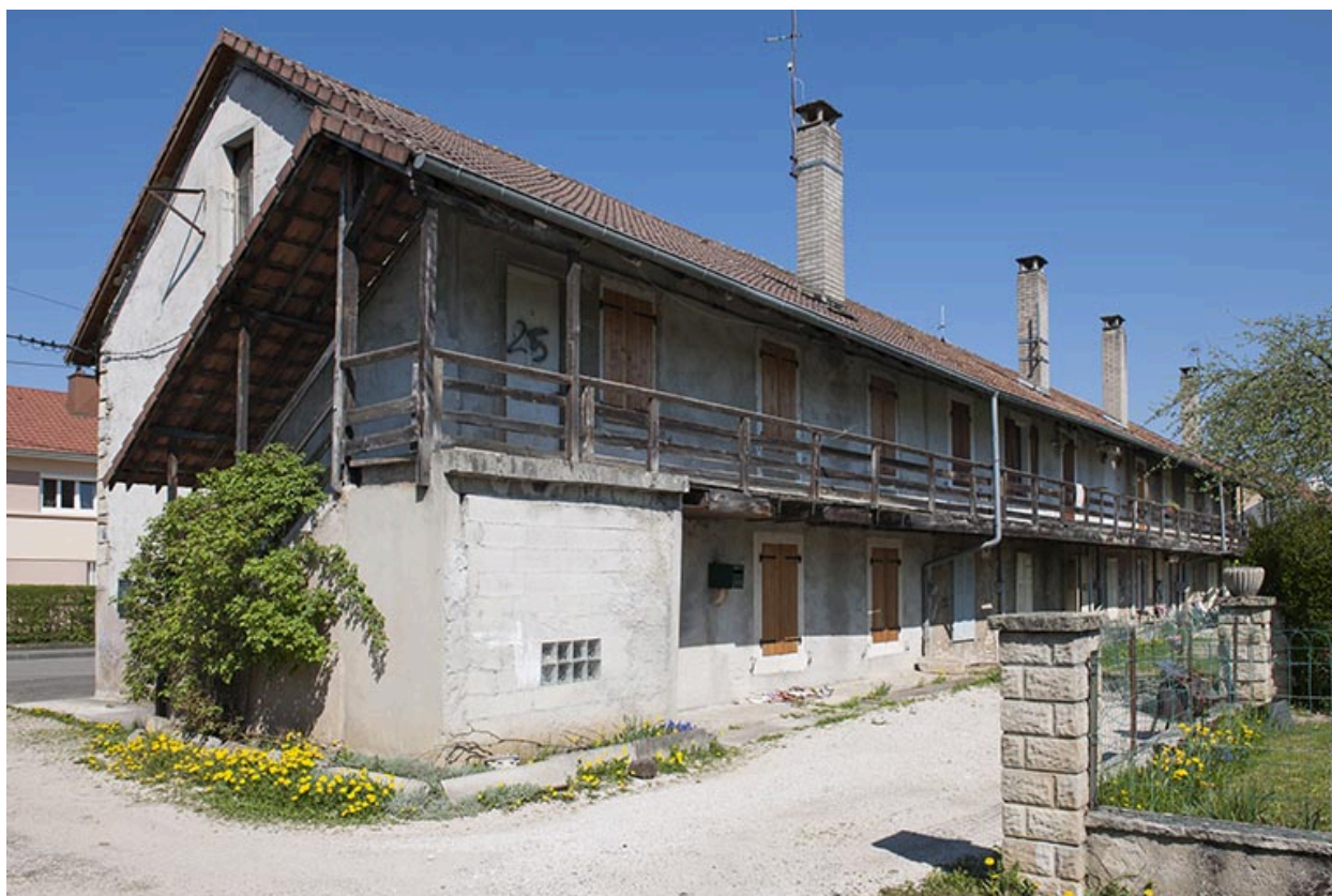
Façade postérieure d'une caserne.
