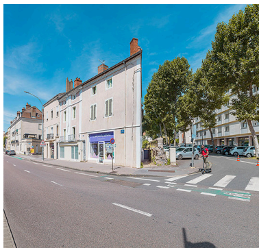
Avenue de Paris, perçant l'ancienne courtine Saint-Pierre. Phot. Thierry Kuntz IVR26_20247100093NUC4A
