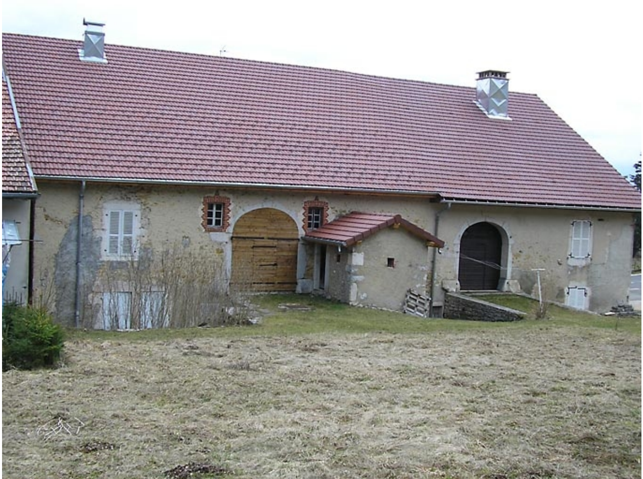
Façade postérieure et ponts de grange.
