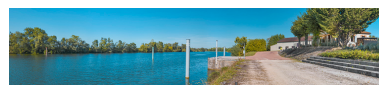
Le site de l'ancien barrage et la maison du barragiste, d'aval. Au fond, le bâtiment de VNF. Phot. Thierry Kuntz IVR26_20192100173NUC4A
