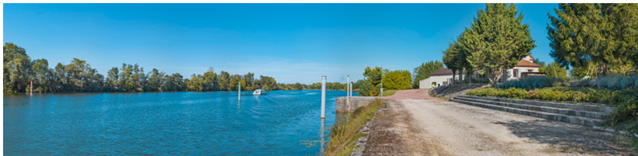
Le site de l'ancien barrage et la maison du barragiste, d'aval. Au fond, le bâtiment de VNF.
