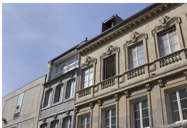
Détail de la surélévation en retrait sur rue. Phot. Yves Sancey IVR43_20102501223NUC2A
