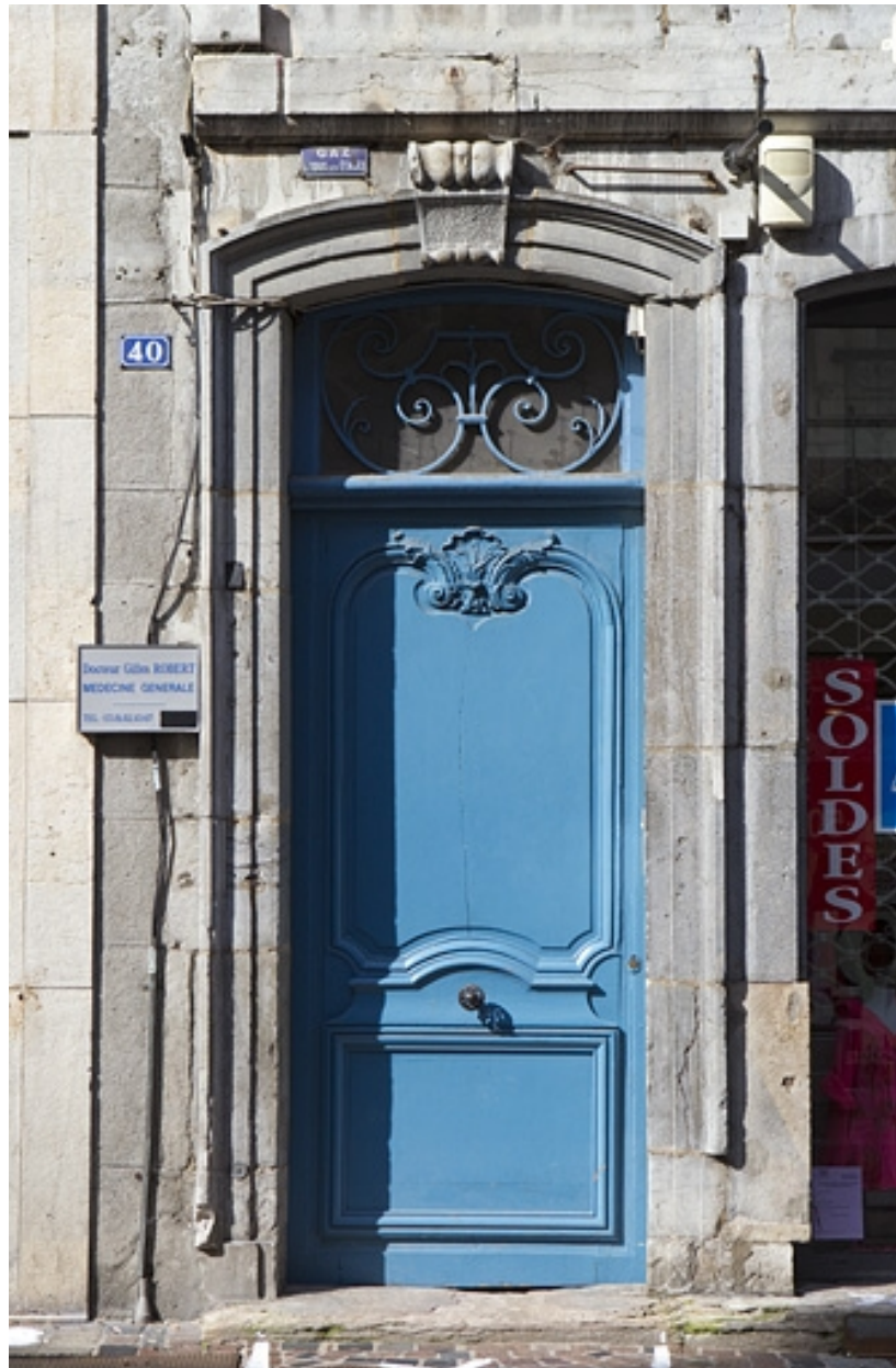
Détail de la porte du couloir d'entrée.
