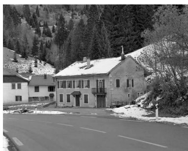
Atelier de trois quarts droite. Phot. Yves Sancey IVR43_19903900366X
