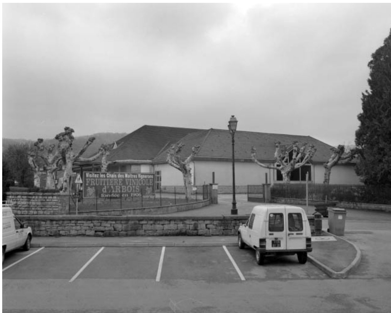
Vue d'ensemble de la nouvelle coopérative vinicole.
