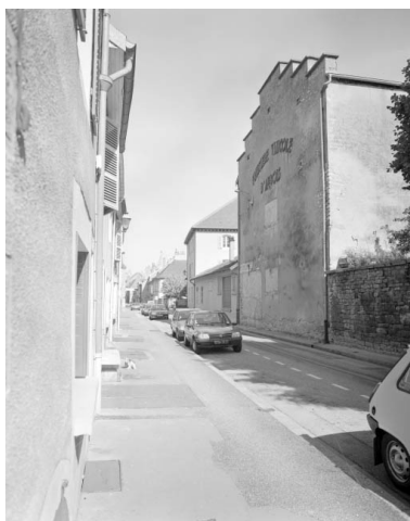
Pignon à redents d'un chai.
