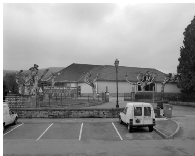
Vue d'ensemble de la nouvelle coopérative vinicole. Phot. Yves Sancey IVR43_19973900517X
