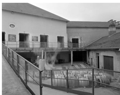
Façades sur cour des chais.
