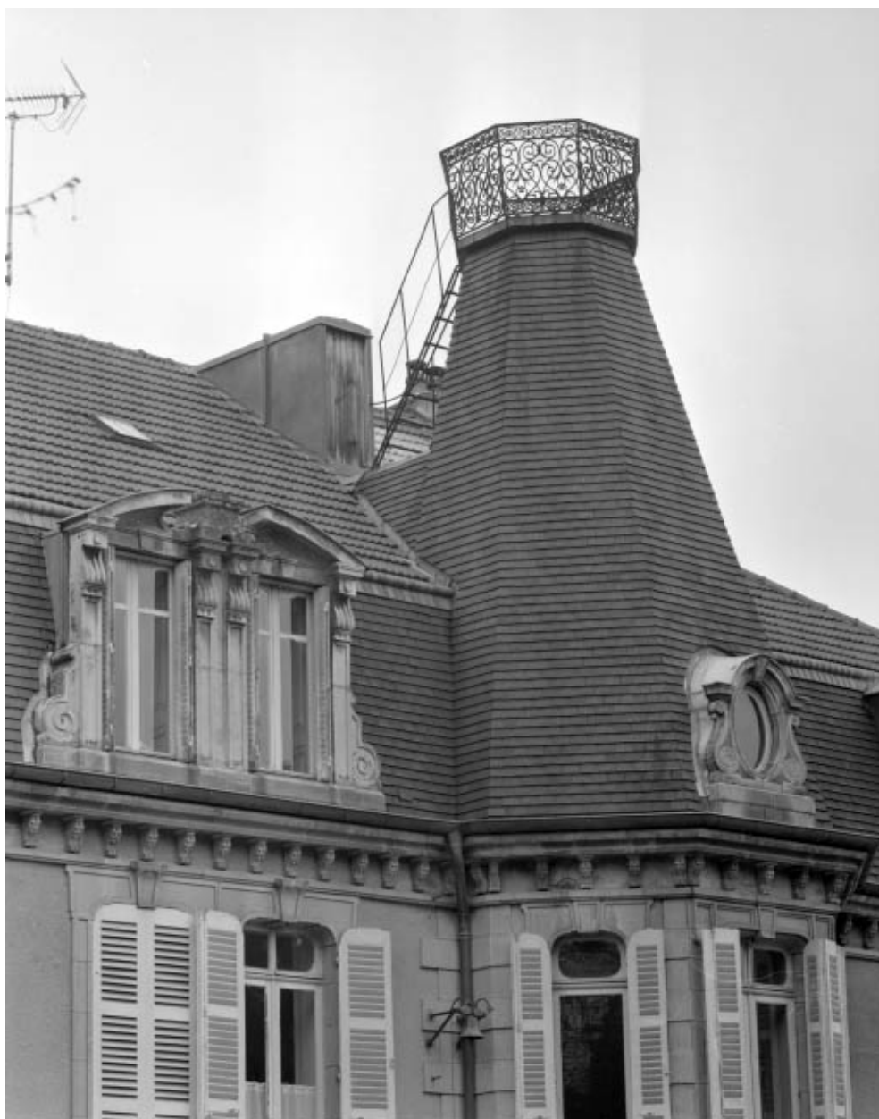
Château Béthanie : toiture de la tourelle d'escalier.
