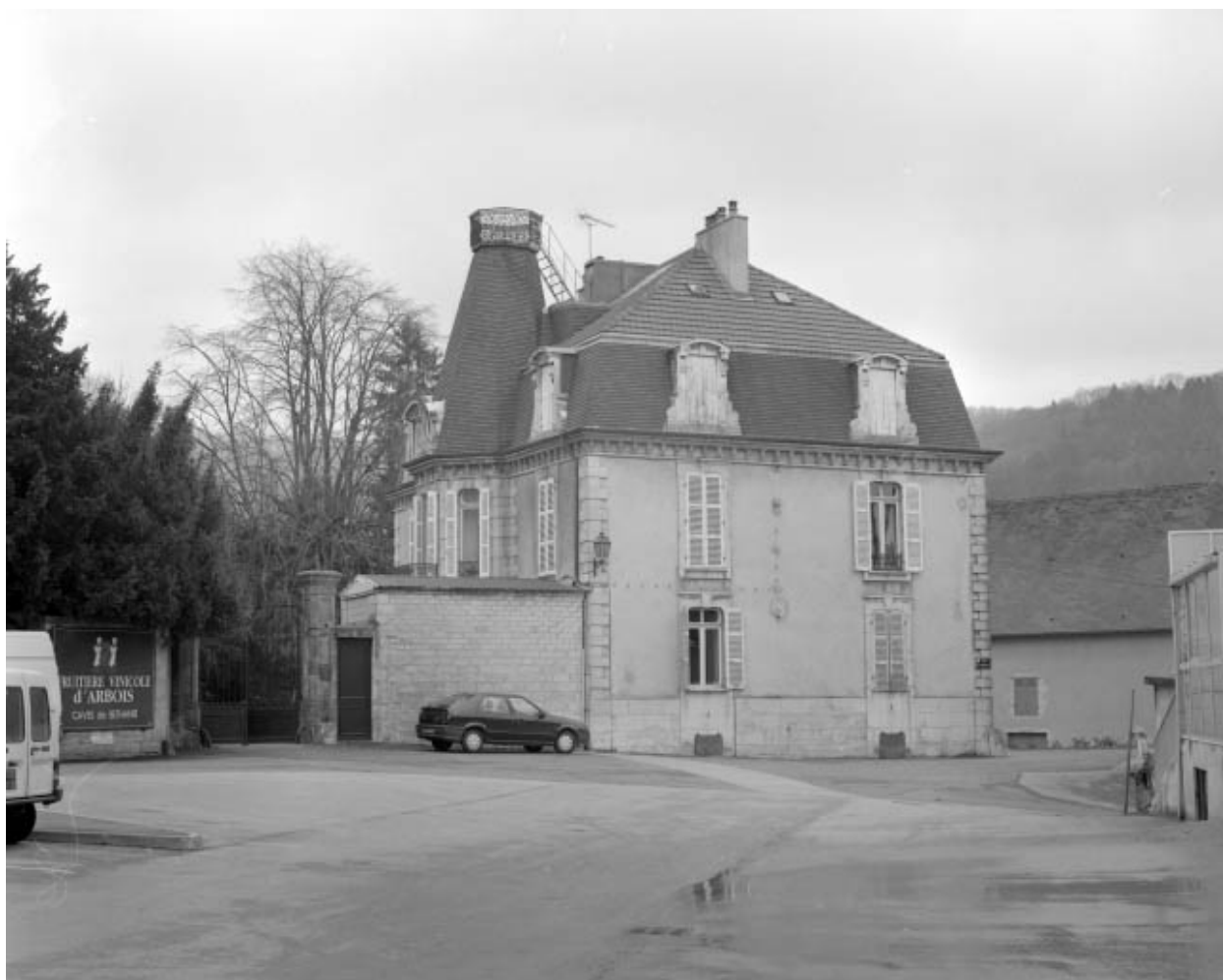
Façade latérale du château Béthanie.
