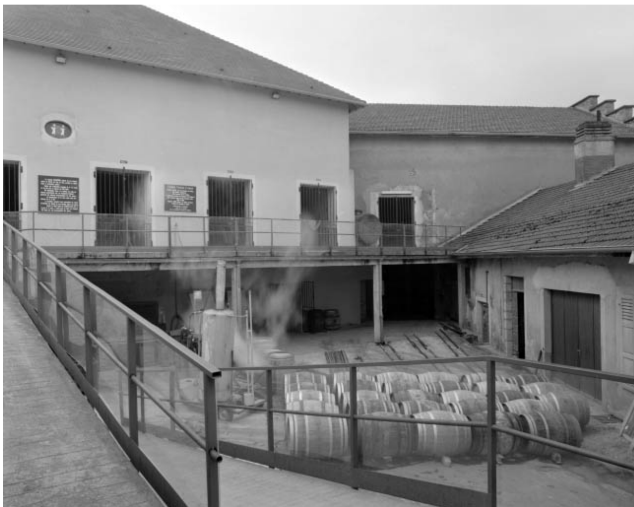
Façades sur cour des chais. Au centre de la cour : fûts de vieillissement du vin jaune.
