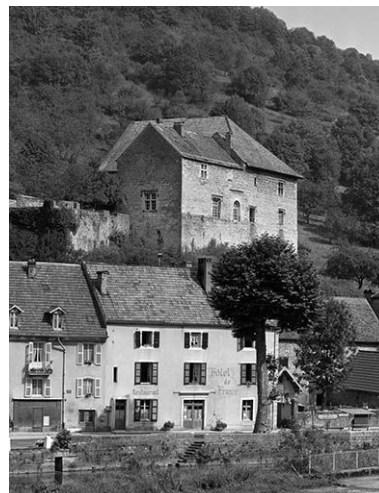
Vue générale, angle sud-ouest. Phot. Yves Sancey IVR43_19802500978X
