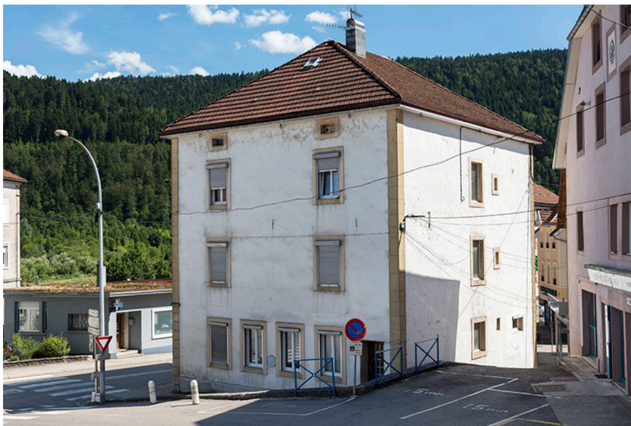
Façades postérieure et latérale droite.
