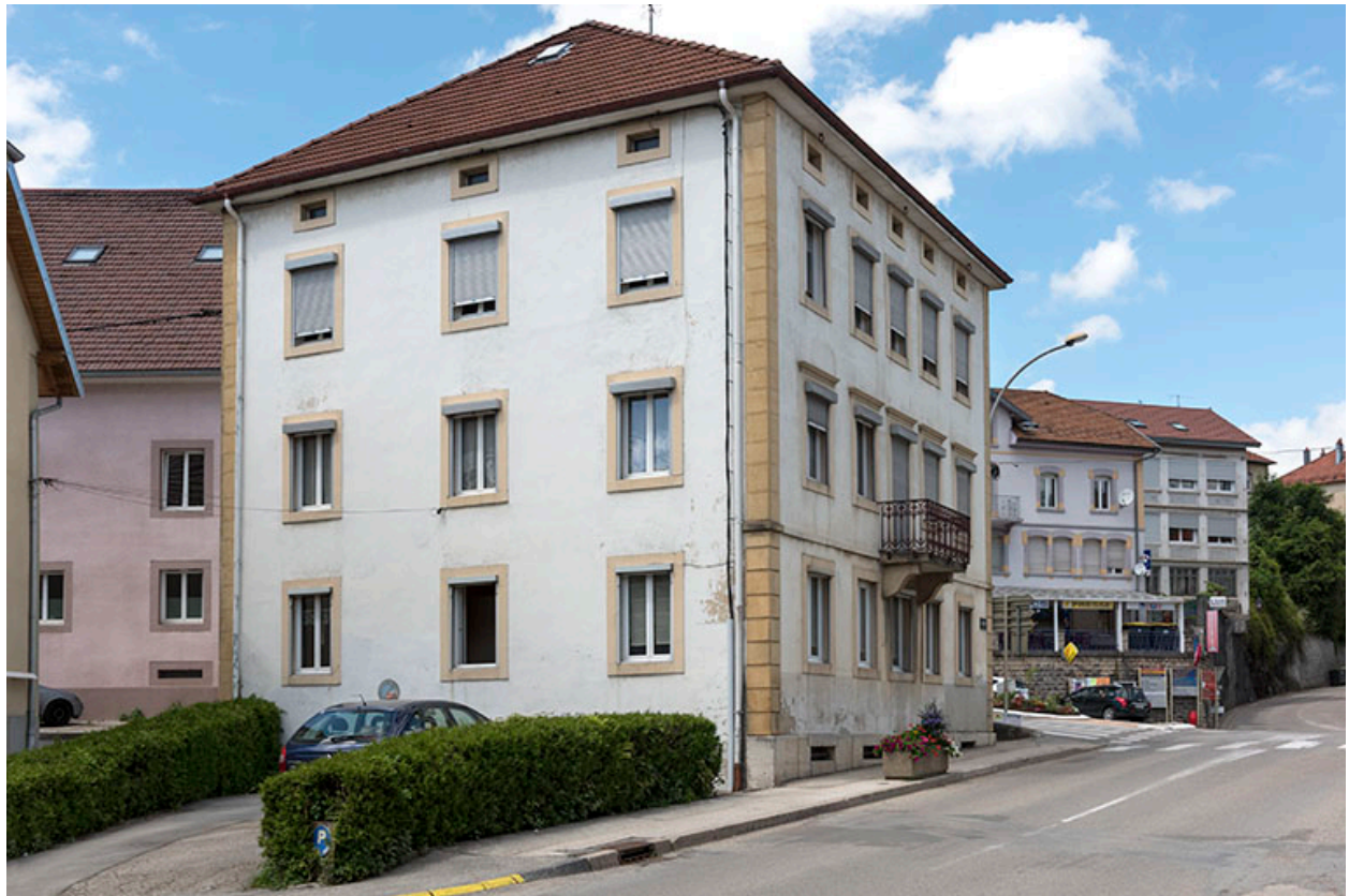
Façades antérieure et latérale gauche.
