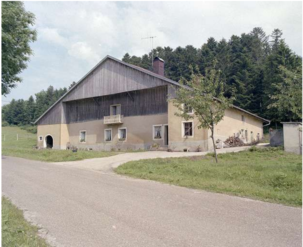
Façades antérieure et latérale droite.
