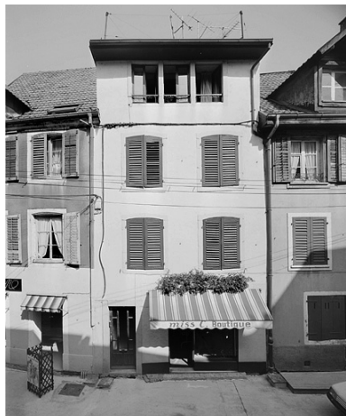
Façade sur rue. Phot. Jérôme Mongreville IVR43_19872501085V
