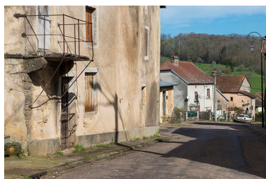
Rue du Vaux. Phot. Jérôme Mongreville IVR43_20187000173NUC4A
