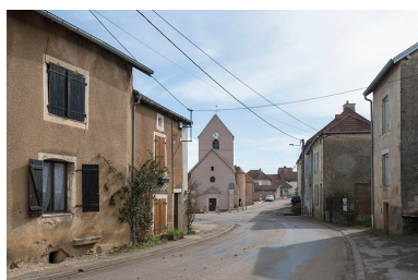
L'église et la rue des Ecoles. Phot. Jérôme Mongreville IVR43_20187000180NUC4A
