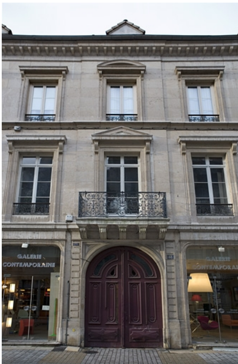
Vue rapprochée de la façade sur rue, de face.
