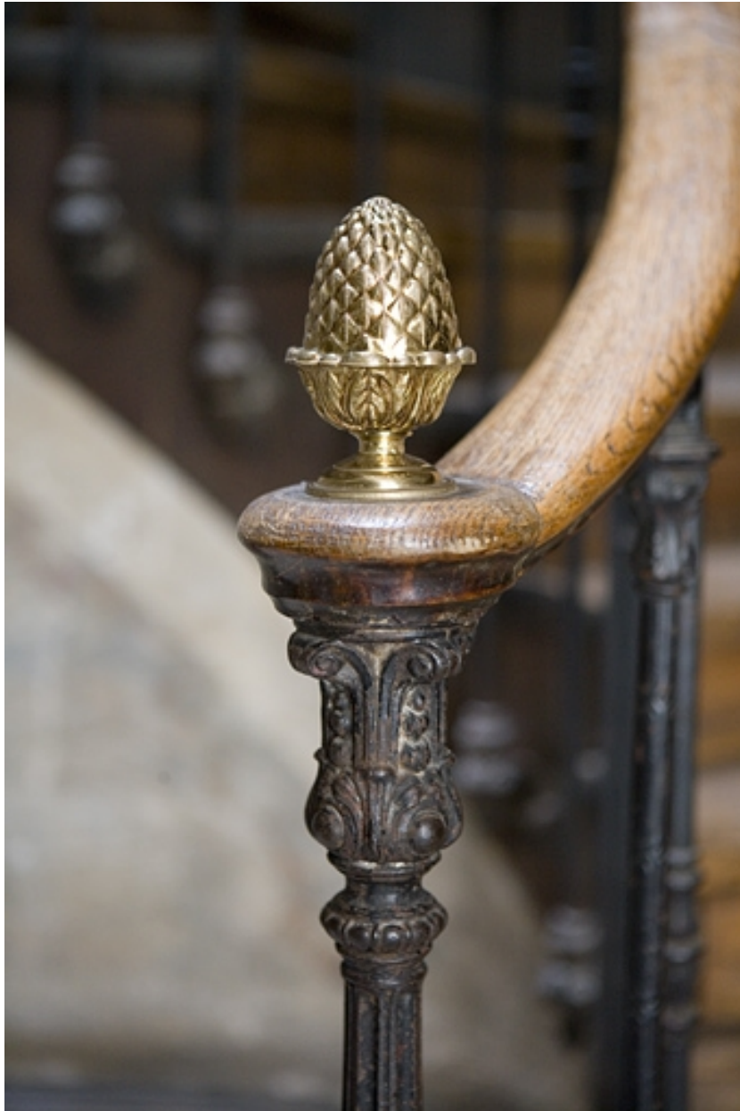
Détail du départ de la rampe d'appui de l'escalier principal.
