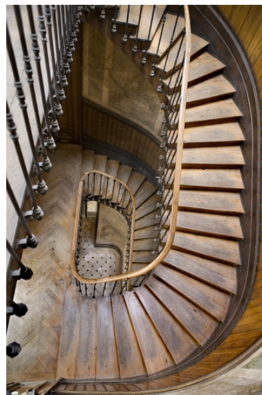
Vue d'ensemble de l'escalier principal depuis le dernier palier. Phot. Yves Sancey IVR43_20082500338NUC2A
