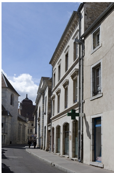
Vue éloignée du logis secondaire situé rue de la Bibliothèque, dans l'alignement de la rue. Phot. Yves Sancey IVR43_20082500335NUC2A
