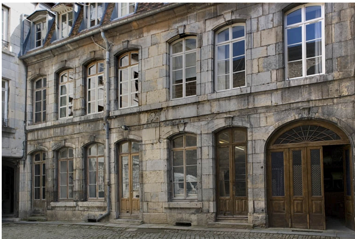
Vue d'ensemble de l'aile gauche sur cour.
