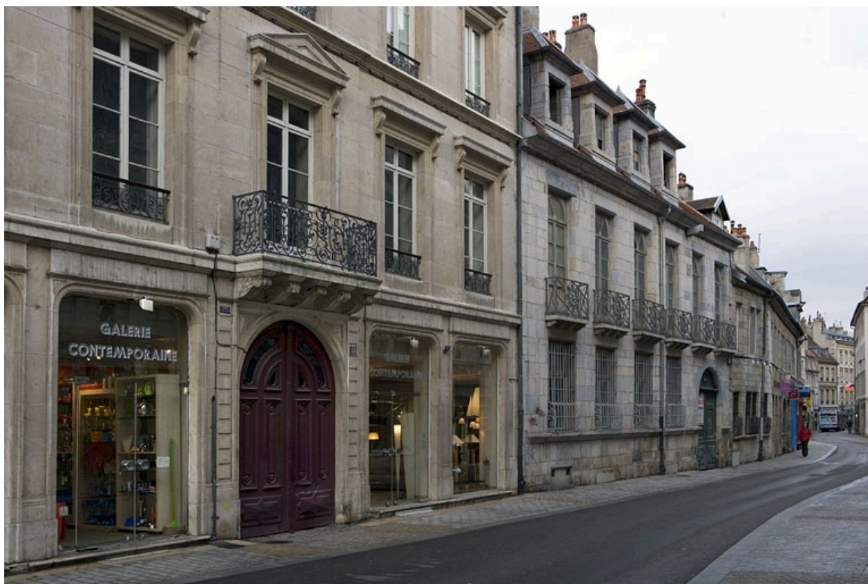
Vue d'ensemble de la façade sur rue, de trois quarts gauche.
