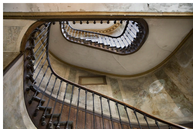
Vue d'ensemble de la cage de l'escalier principal depuis le bas. Phot. Yves Sancey IVR43_20082500339NUC2A
