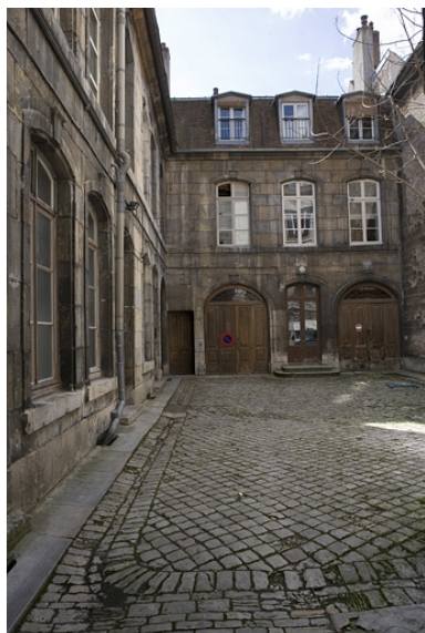
Vue d'ensemble de l'aile en fond de cour. Phot. Yves Sancey IVR43_20082500337NUC2A
