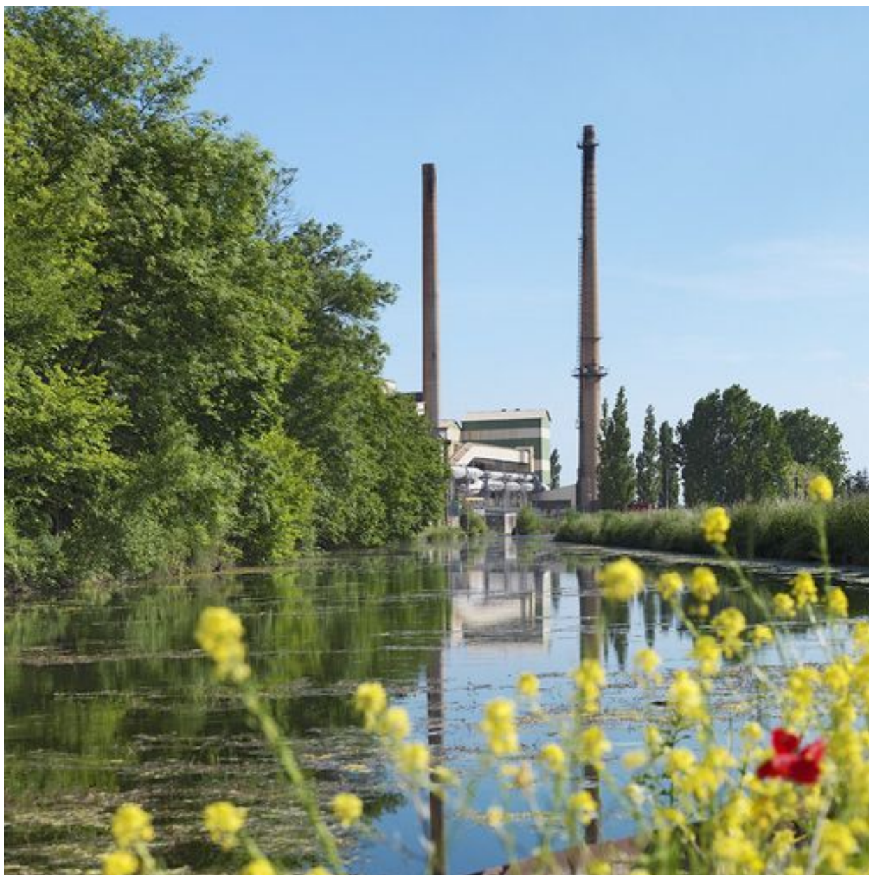
Vue générale de l'usine depuis l'embranchement.
