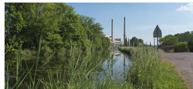
L'embranchement avec l'usine Véralia à droite. Phot. Thierry Kuntz IVR26_20137100266NUC4A
