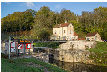
Vue générale. Phot. Sonia Dourlot IVR43_20157000201NUC2A
