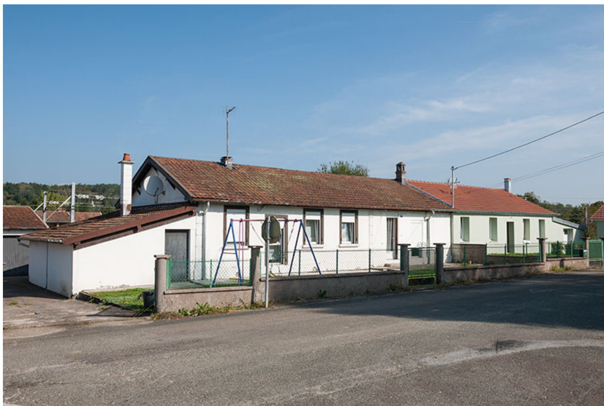
Habitation en rez-de-chaussée (3 logements).
