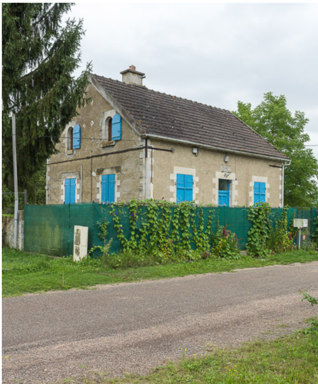
Vue de la maison éclusière.
