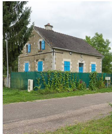
Vue de la maison éclusière. Phot. Pierre-Marie Barbe-Richaud IVR26_20175800446NUC2A
