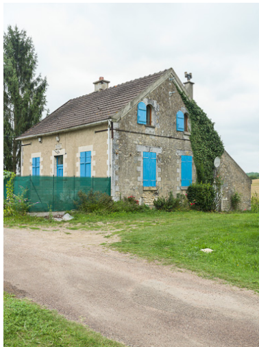
Vue de la maison éclusière. Phot. Pierre-Marie Barbe-Richaud IVR26_20175800445NUC2A
