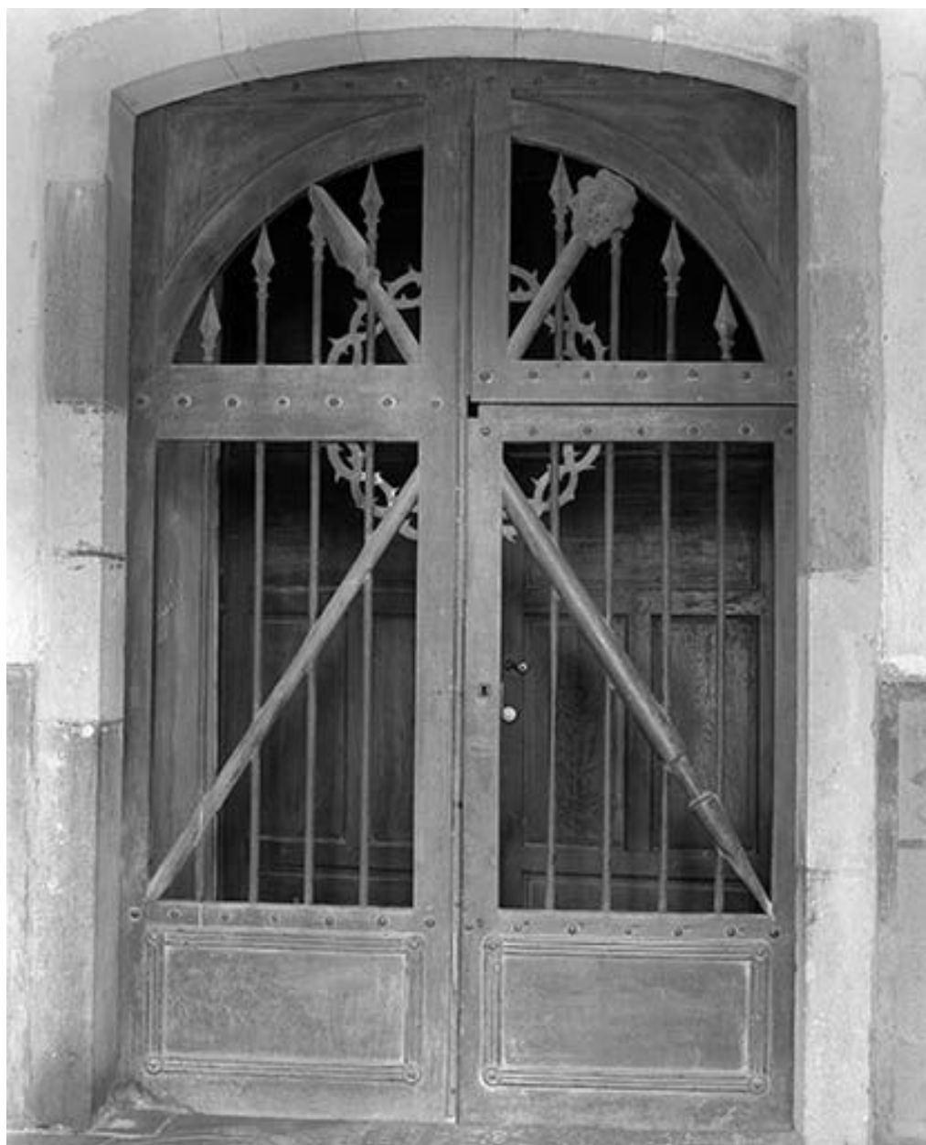
Porte conduisant à la nef.
