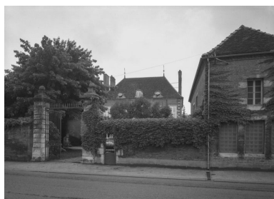
Maison de notable, 18 rue du Faubourg Saint-Georges. Phot. Michel Rosso IVR26_19862100821V
