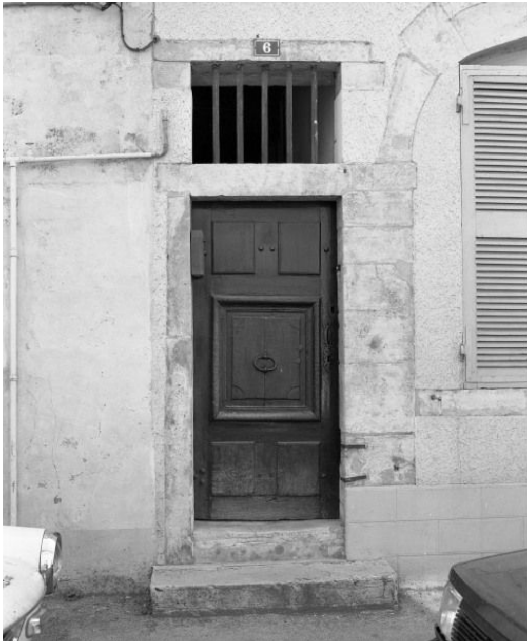
Maison, 6 rue Dulac. Détail : porte.
