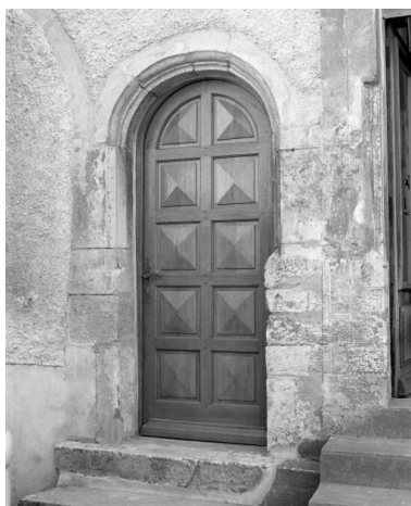
Porte de la maison située au 32 rue Dulac. Phot. Michel Rosso IVR26_19862100759X
