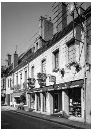
Alignement de maisons, 55-59 rue de la République. Phot. Michel Rosso IVR26_19862100865V
