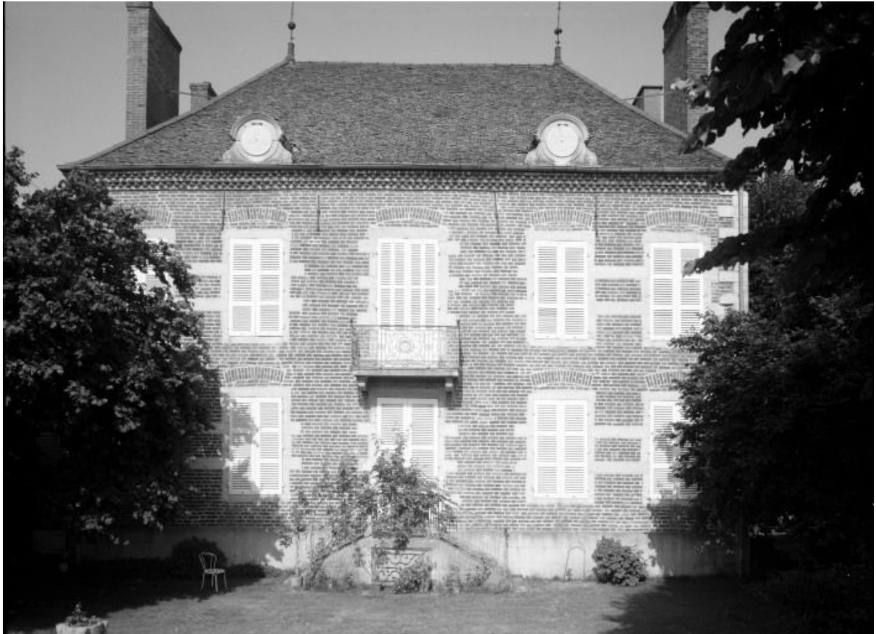
Façade postérieure d'une maison de notable, 18 rue du Faubourg Saint-Georges.
