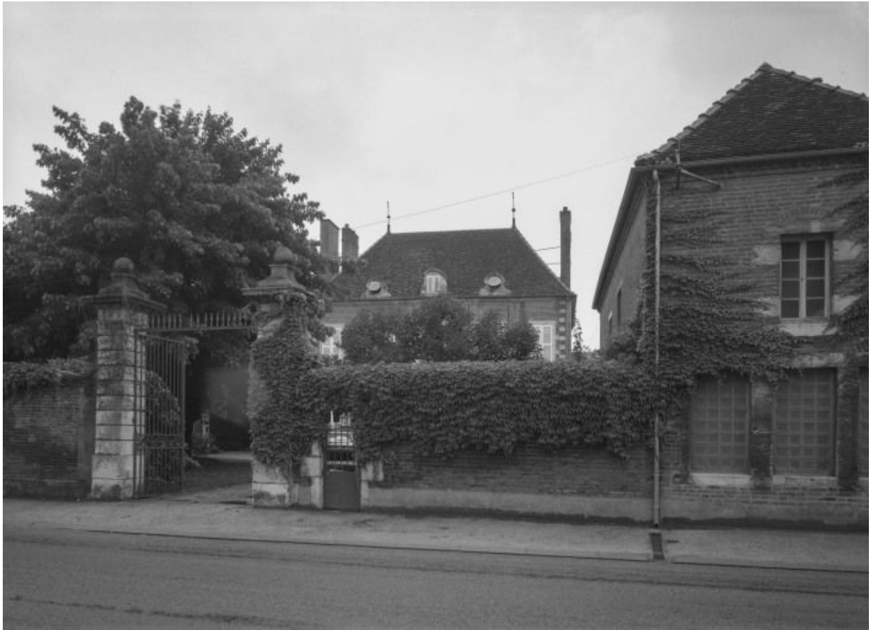
Maison de notable, 18 rue du Faubourg Saint-Georges.
