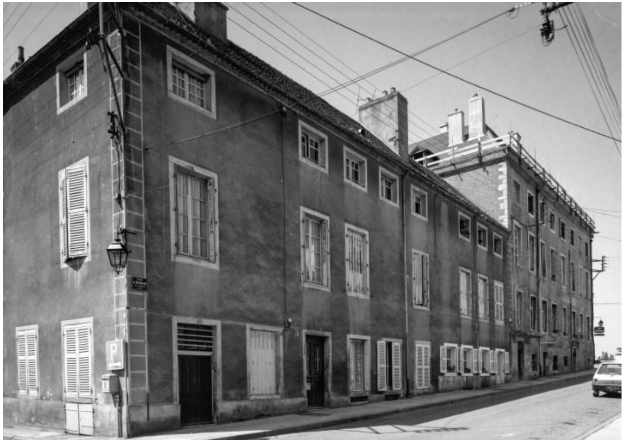
Alignement de maisons, 35-37 rue de Beuraing.
