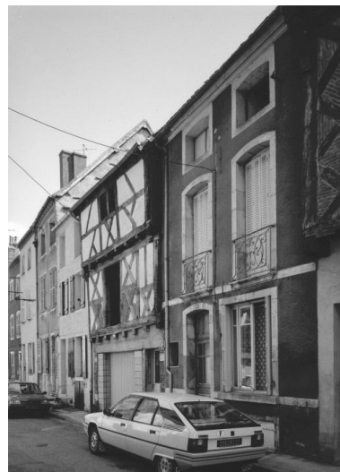
Alignement de maisons, rue Dulac. Phot. Michel Rosso IVR26_19862100757V
