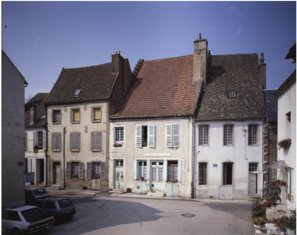
Alignement de maisons, rue Dulac.
