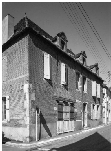
Vue d'ensemble d'une maison, 6 rue du Château. Phot. Michel Rosso IVR26_19862100762V
