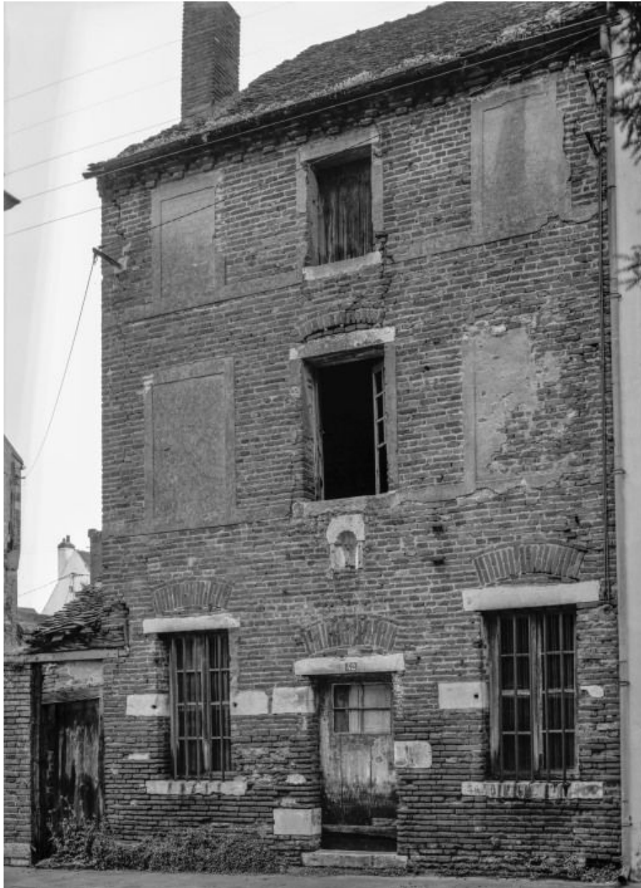
Façade d'une maison, 42 rue Dulac.
