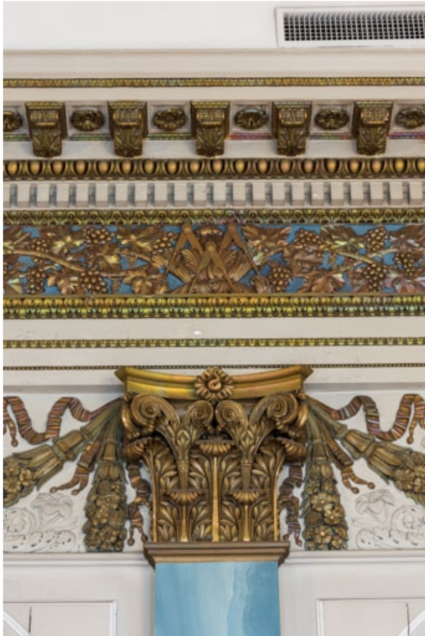
Chapiteau surmonté de l'entablement avec un motif des compas dans la frise.
