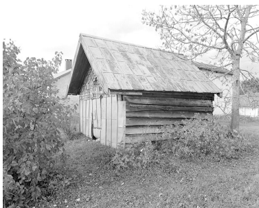
Le grenier fort. Phot. Jérôme Mongreville IVR43_19963901500X
