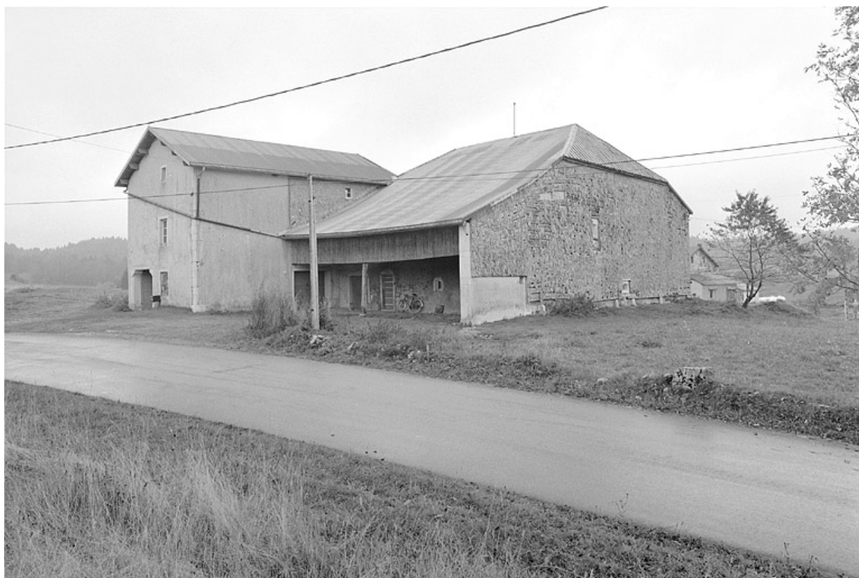
Façade postérieure et face ouest.
