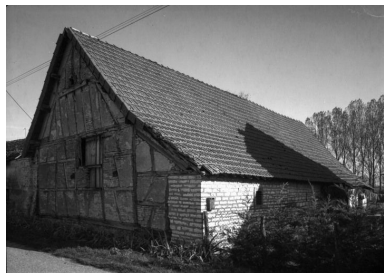
Ferme (cada 1943 D5 896) : bâtiment des dépendances, façade sur cour. Phot. Michel Rosso IVR26_19867100236V
