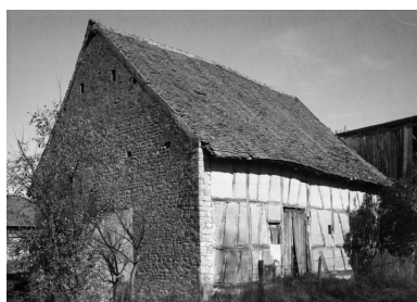
Ferme (cada 1943 D5 870) : bâtiment des dépendances. Phot. Michel Rosso IVR26_19867100241V
