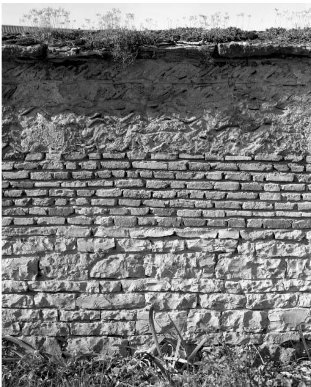
Ferme (cada 1943 D5 894) : détail d'un mur de clôture.
