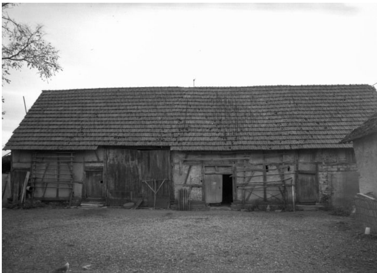
Ferme (cada 1943 D5 896) : bâtiment des dépendances, vue de trois-quarts.
