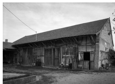
Ferme (cada 1943 C5 557) : bâtiment des dépendances. Phot. Michel Rosso IVR26_19867100251V
