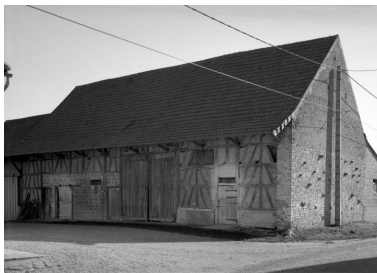
Ferme (cada 1943 D5 815) : bâtiment des dépendances. Phot. Michel Rosso IVR26_19867100245V
