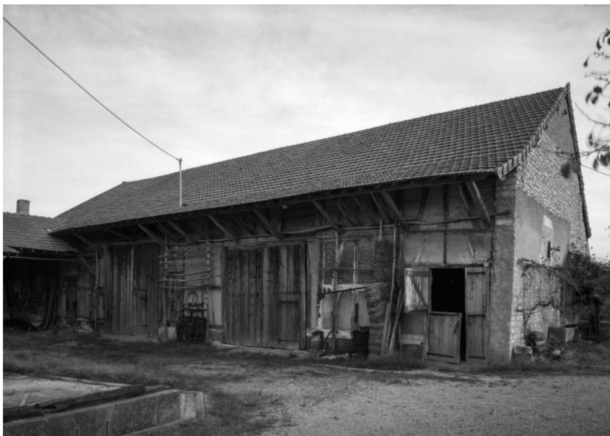
Ferme (cada 1943 C5 557) : bâtiment des dépendances.
