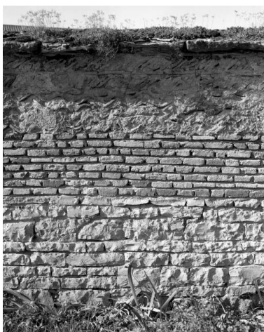
Ferme (cada 1943 D5 894) : détail d'un mur de clôture. Phot. Michel Rosso IVR26_19867100238X
