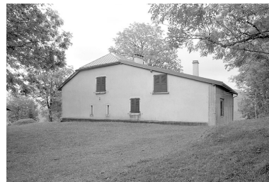
Façade postérieure de la fromagerie. Phot. Jérôme Mongreville IVR43_19963901267X
