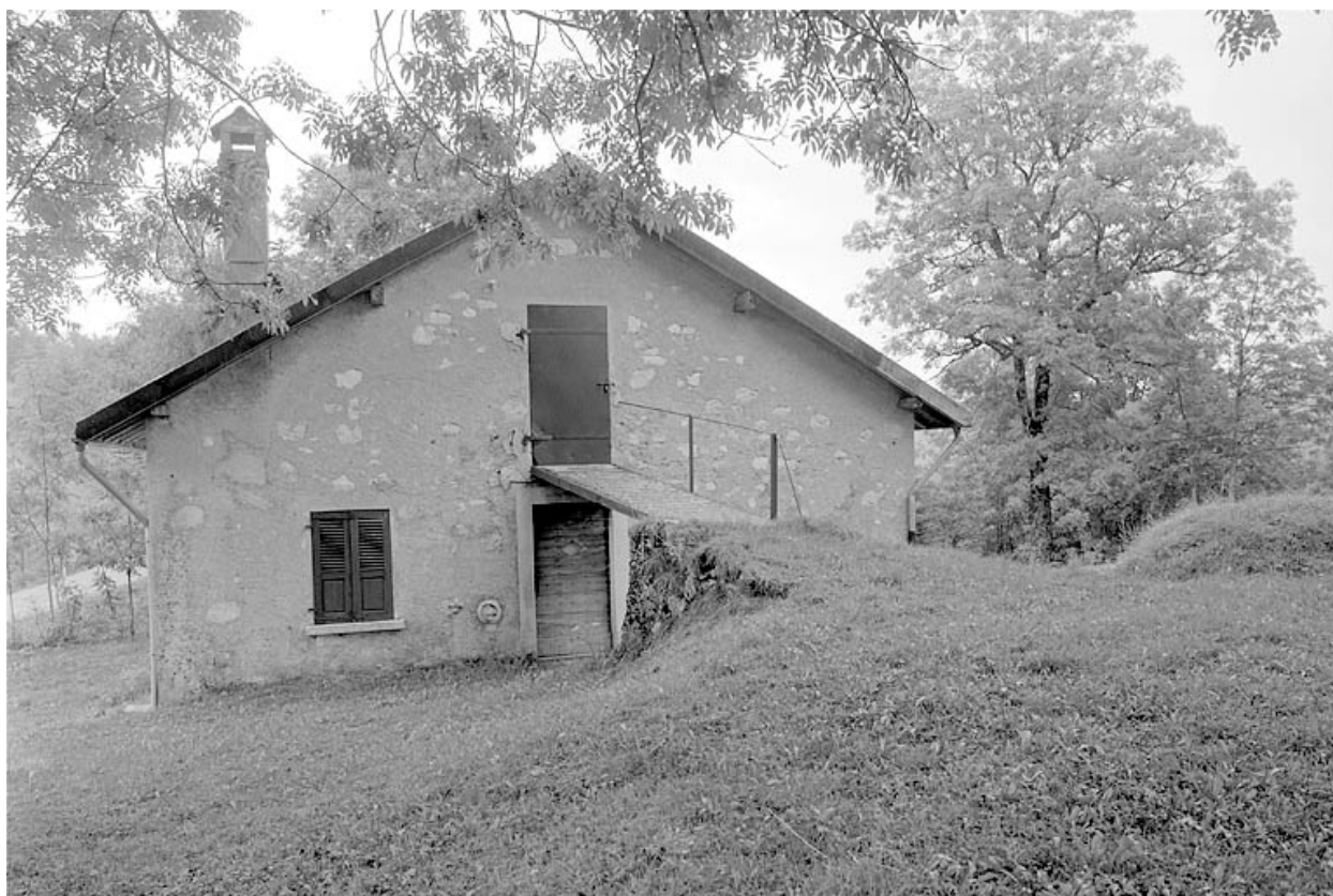
Face sud-ouest de la porcherie.
