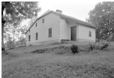
Façade antérieure de la fromagerie. Phot. Jérôme Mongreville IVR43_19963901266X
