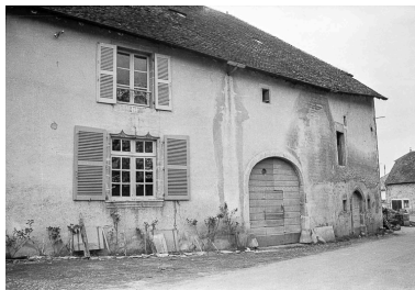
Fenêtre à double accolade. Phot. Guy Forestier IVR43_19743900746Z
