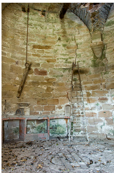
Mur circulaire du donjon. Phot. Sonia Dourlot IVR43_20157001264NUC2A
