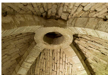
Détail de la clé de voûte. Phot. Sonia Dourlot IVR43_20157001260NUC2A
