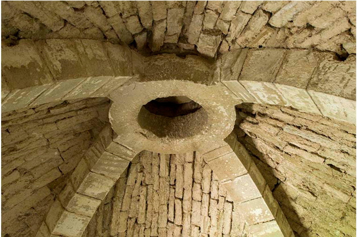
Détail de la clé de voûte.
