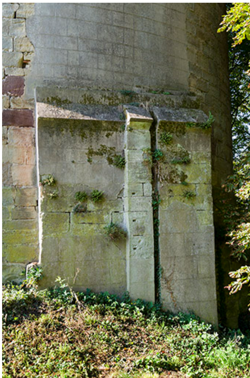
Emplacement probable d'une ancienne porte.
