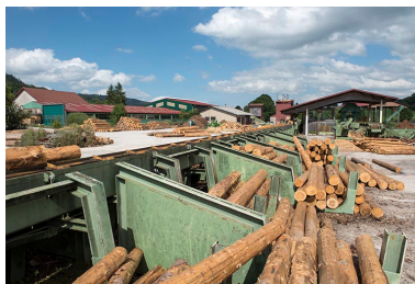
Scierie Boillot : vue partielle des installations. Phot. Sonia Dourlot IVR43_20172501068NUC4A
