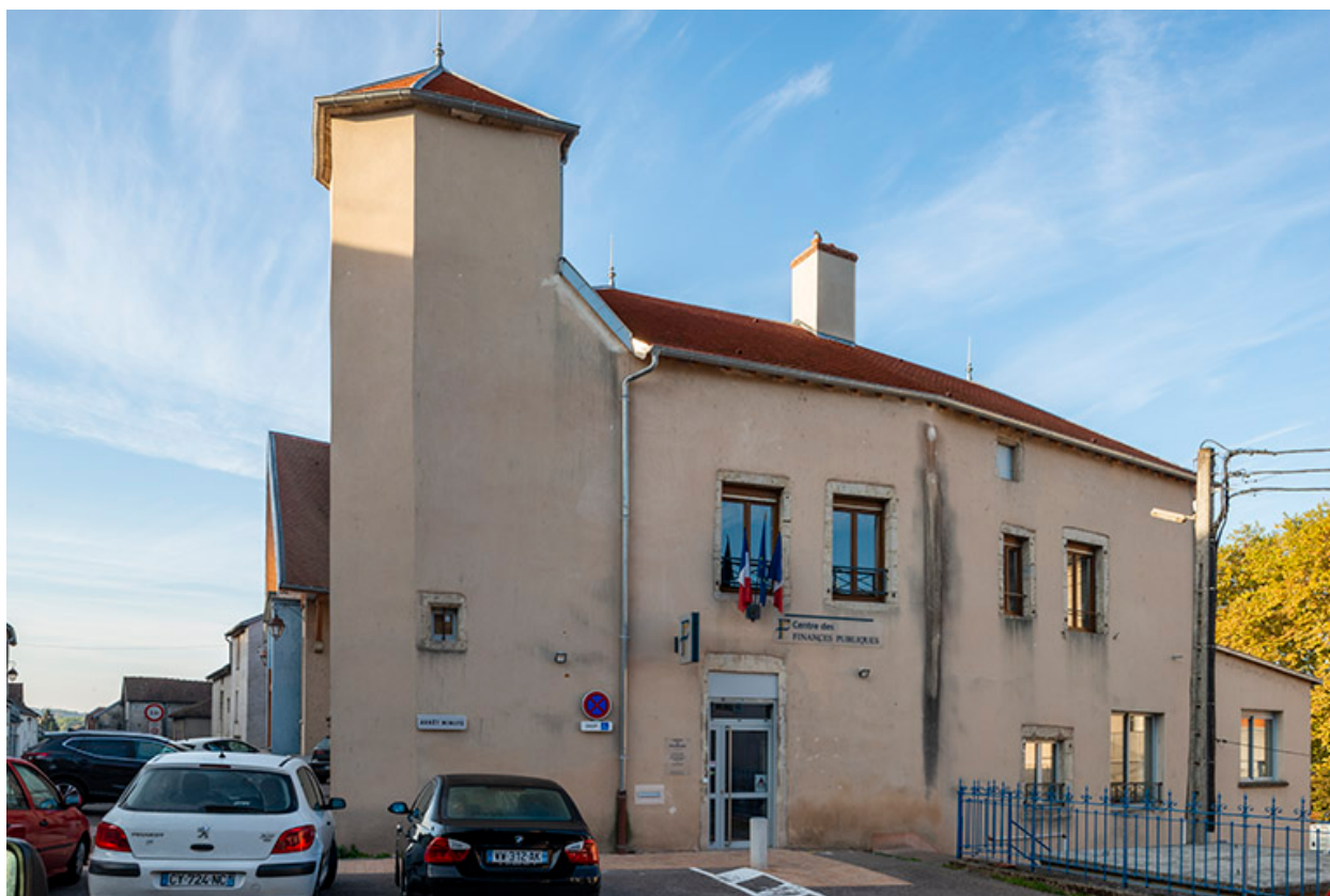
Vue nord de l'édifice.
