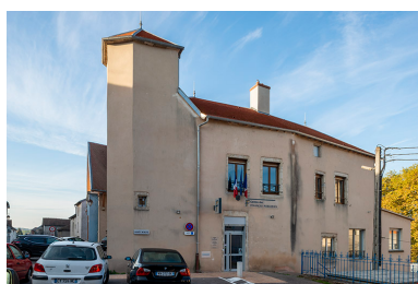
Vue nord de l'édifice. Phot. Jérôme Mongreville IVR43_20187000745NUC4A
