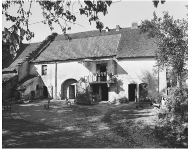
Façade antérieure. Phot. Dominique Dominguez IVR43_19803900031X
