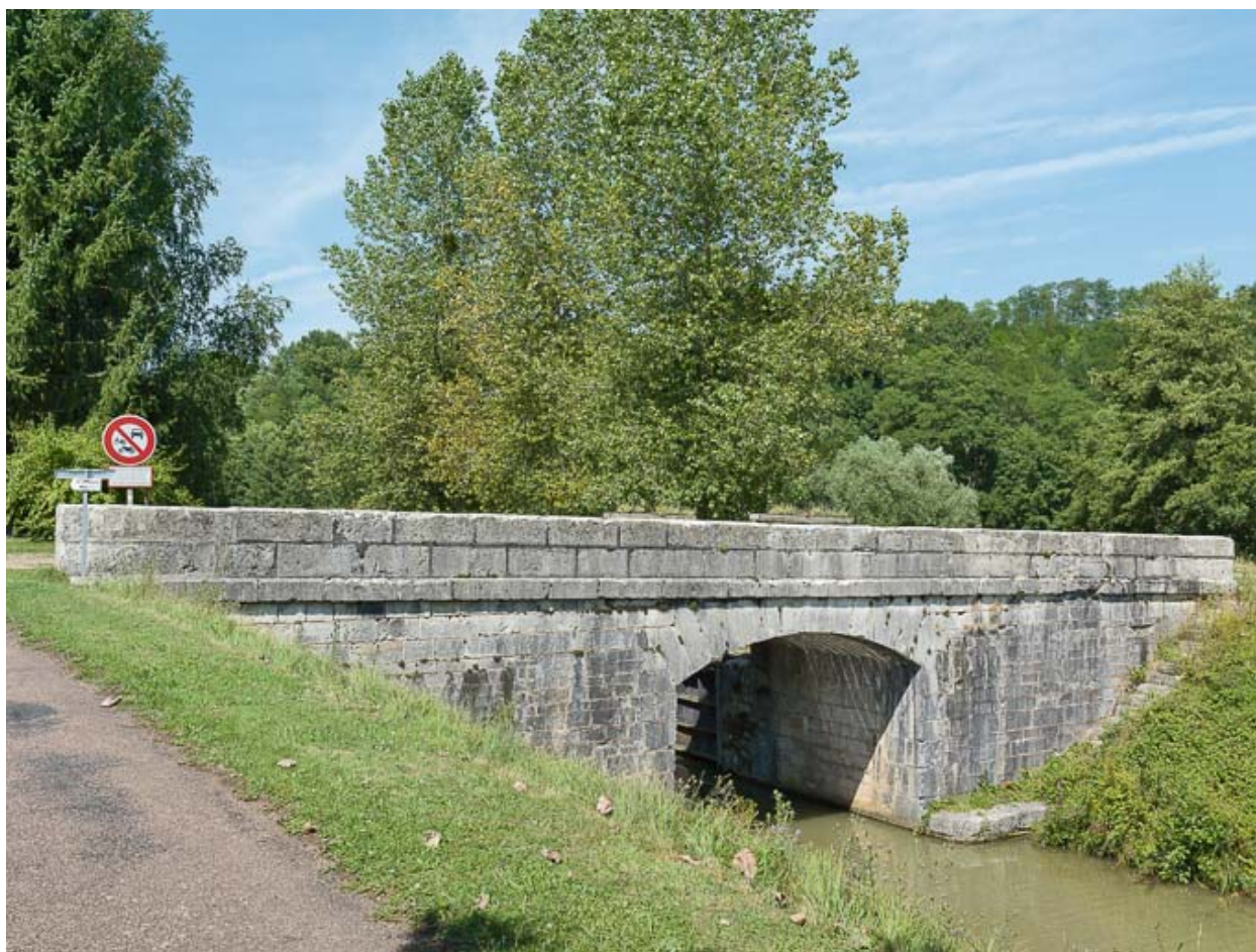
Vue d'ensemble du pont.
