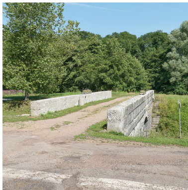
Vue du pont. Phot. Pierre-Marie Barbe-Richaud IVR26_20175800138NUC2A
