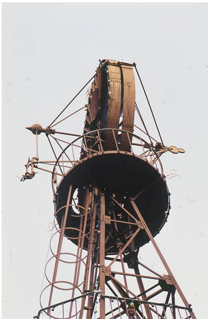
Détail : la passerelle sommitale et l'aéromoteur, vus en contre-plongée.
