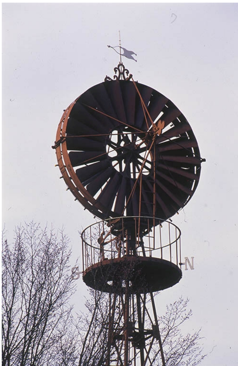
Détail : la passerelle sommitale et l'aéromoteur.
