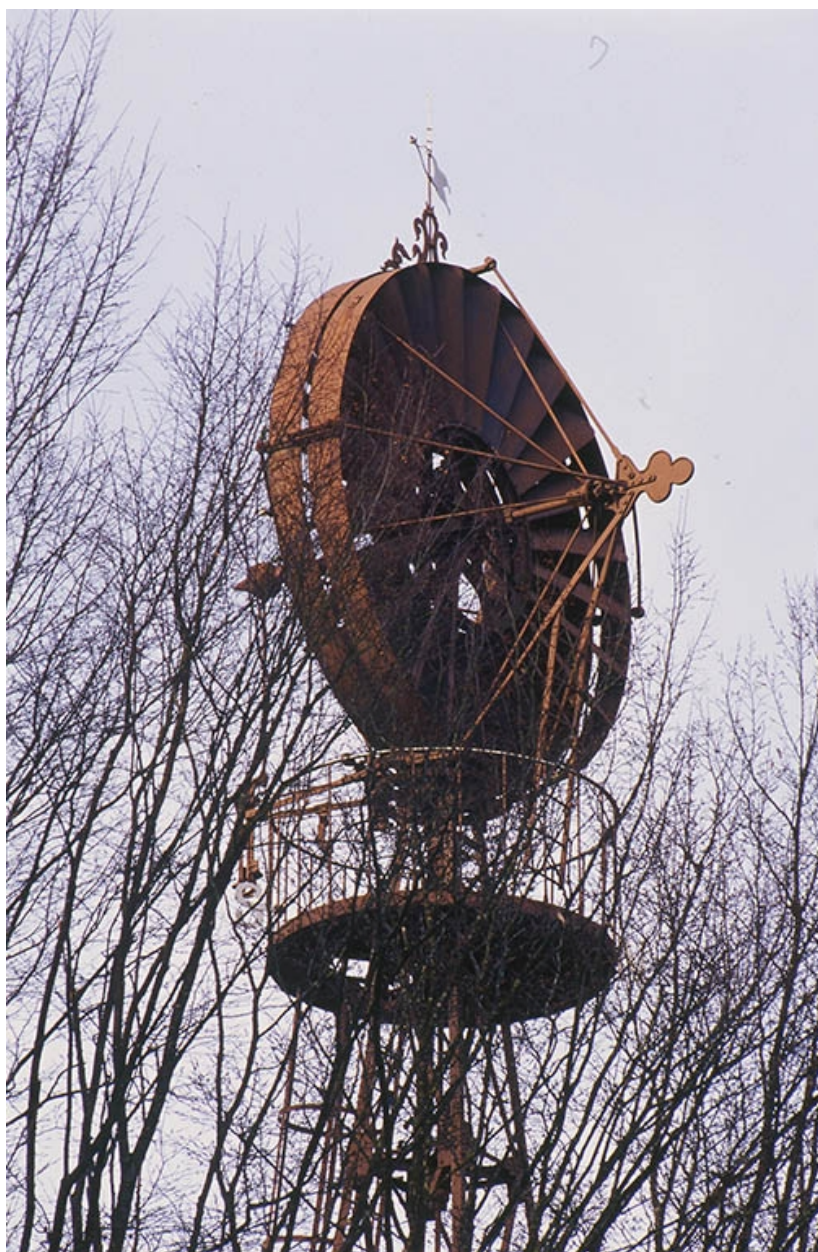
Détail : la passerelle sommitale et l'aéromoteur.
