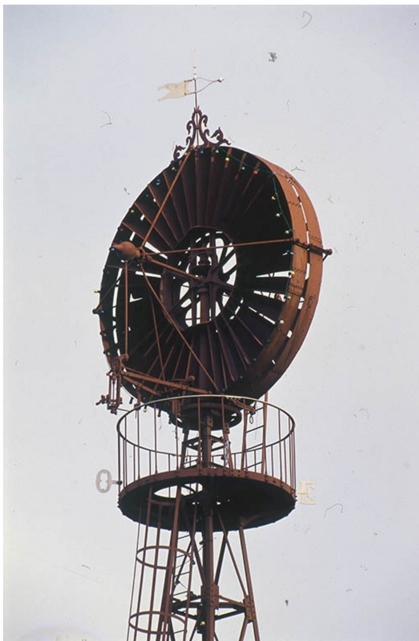
Détail : la passerelle sommitale et l'aéromoteur.
