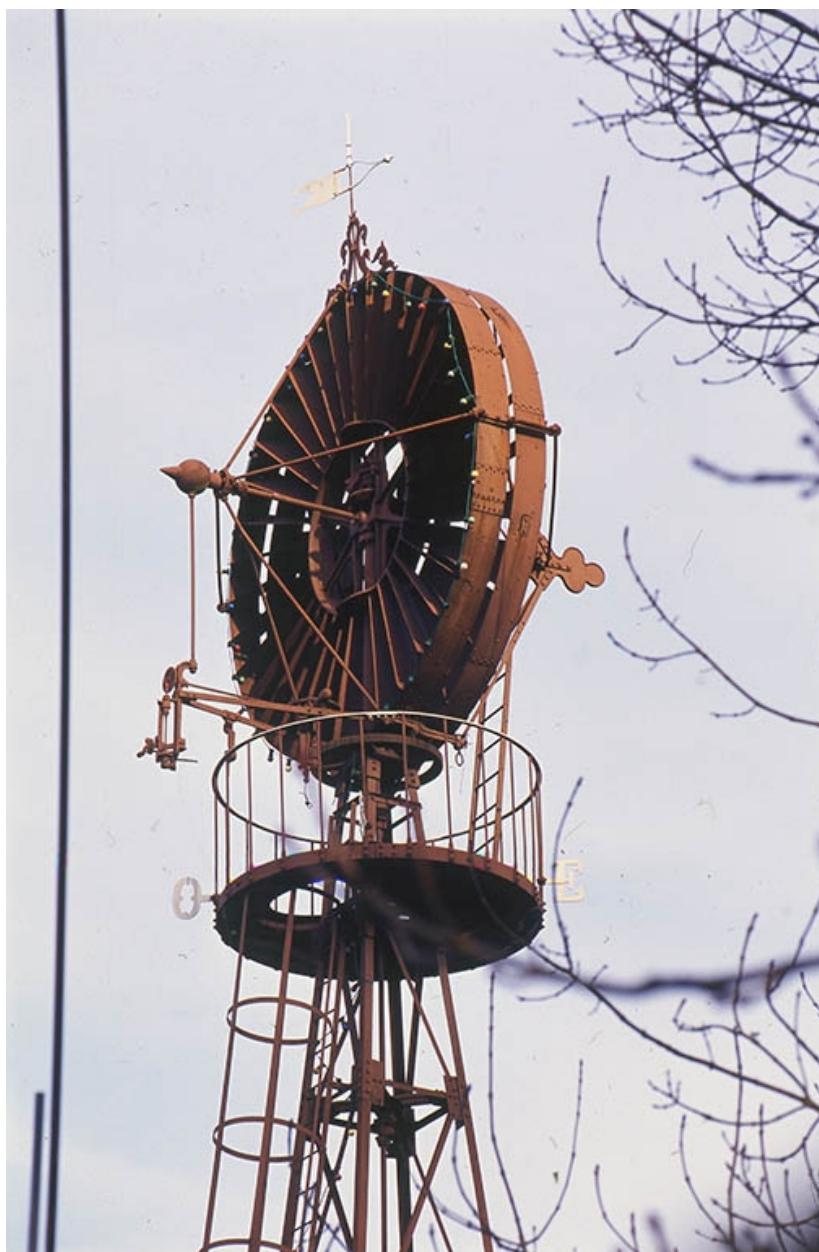
Détail : la passerelle sommitale et l'aéromoteur.
