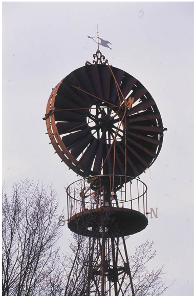
Détail : la passerelle sommitale et l'aéromoteur. Phot. Jean-Luc Duthu IVR26_20028900059ZA
