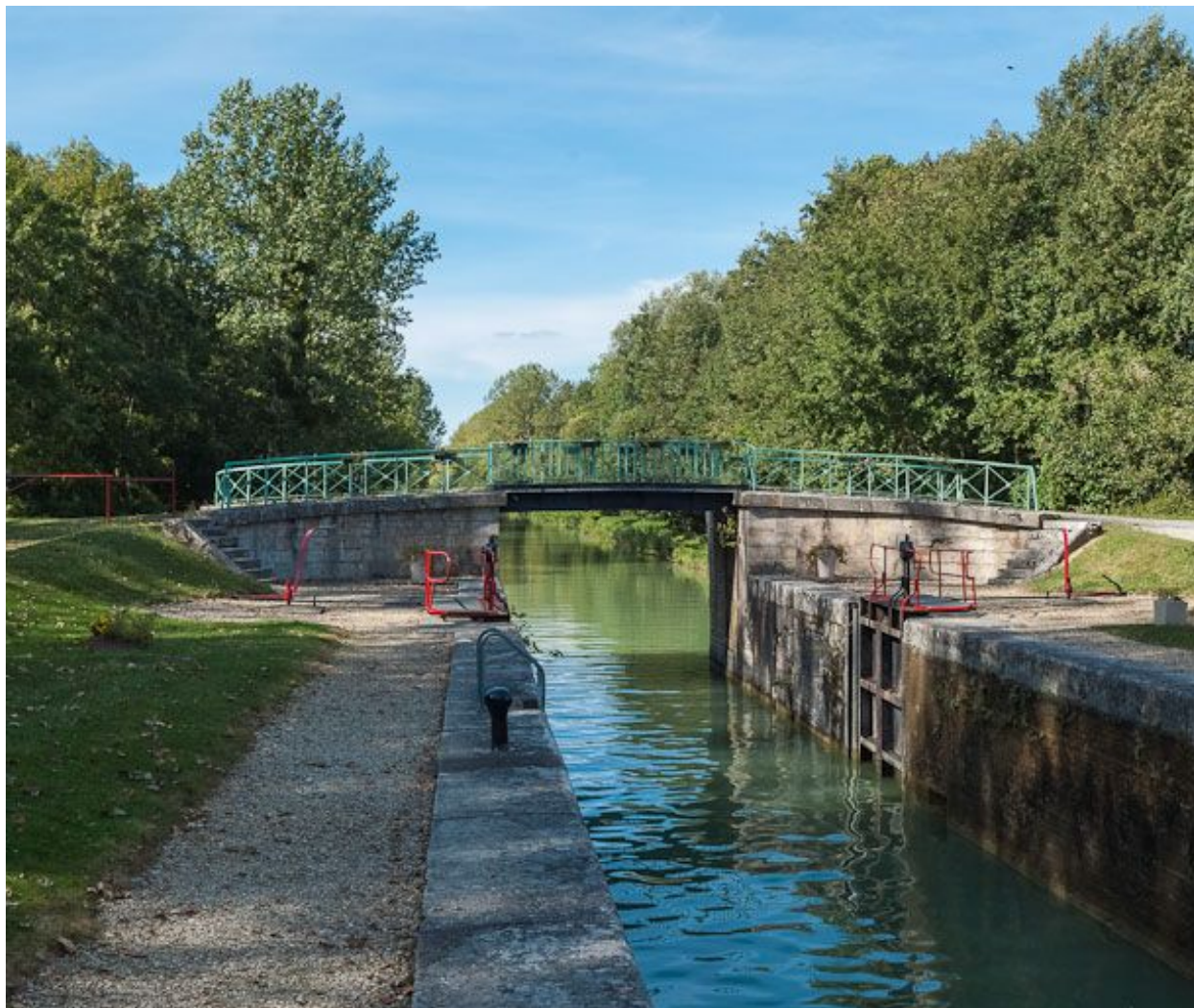
Vue du pont depuis le sas.
