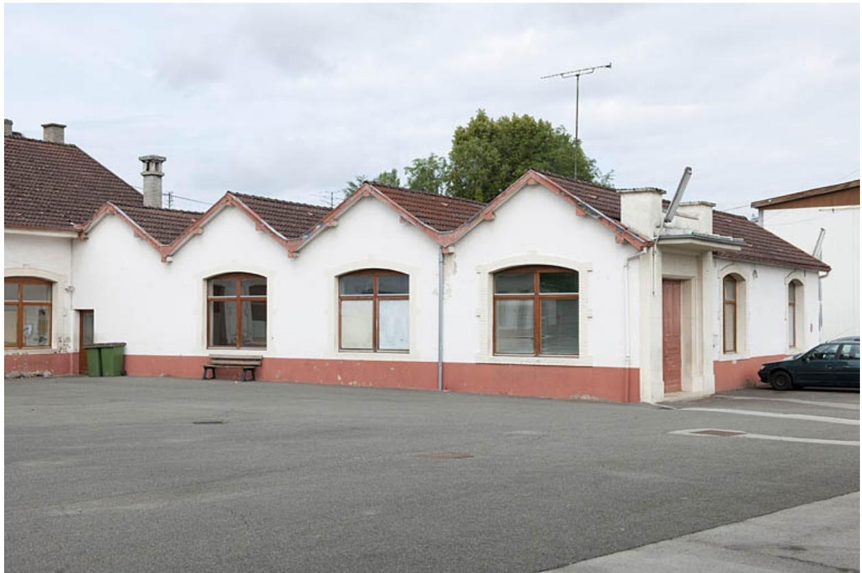
Pignons des magasins industriels.
