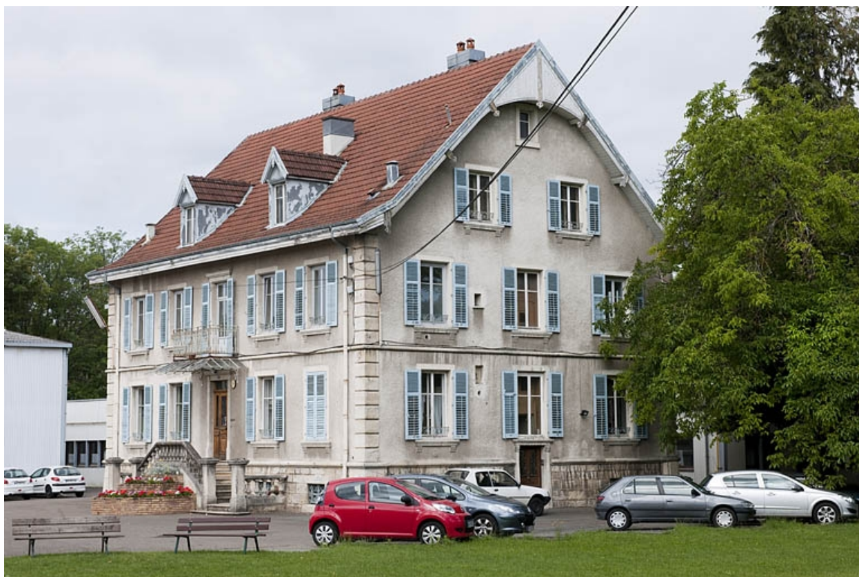
Logement patronal vu de trois quarts.
