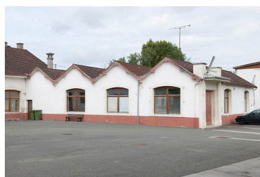
Pignons des magasins industriels. Phot. Jérôme Mongreville IVR43_20112501453NUC4A
