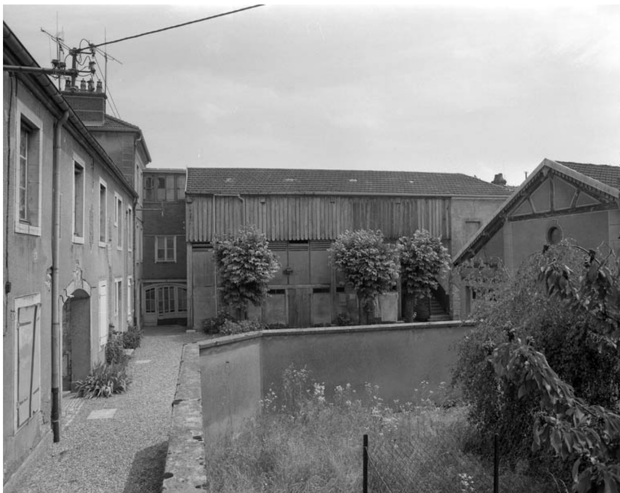
Entrepôt commercial à gauche de la cour.
