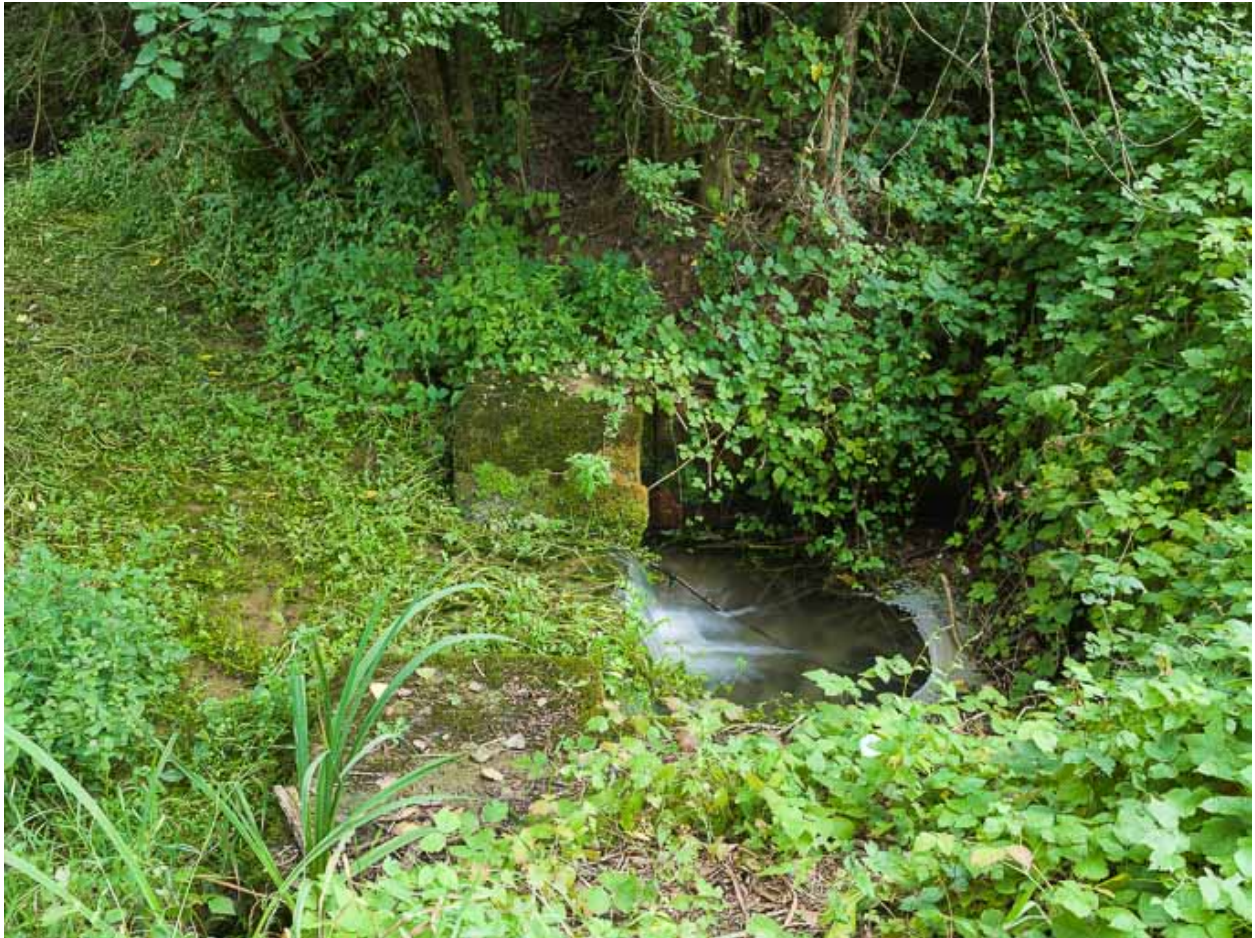
Vue de l'aqueduc dans la végétation.
