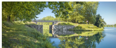
Vue d'ensemble d'amont. Phot. Thierry Kuntz IVR26_20162101313NUC4A
