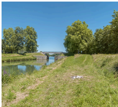
Vue d'ensemble d'aval. Phot. Thierry Kuntz IVR26_20162101314NUC4A
