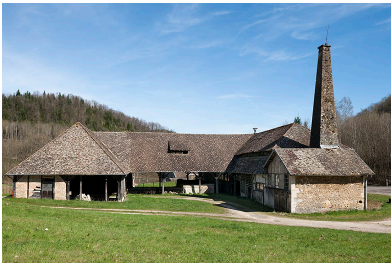
Vue rapprochée depuis l'ouest.
