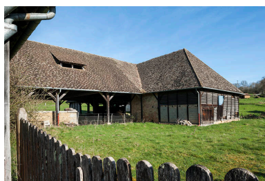
Le bâtiment du four et l'entrepôt industriel vus de trois quarts. Phot. Jérôme Mongreville IVR43_20152501078NUC4A
