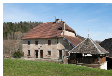
Logement vu de trois quarts droite.
