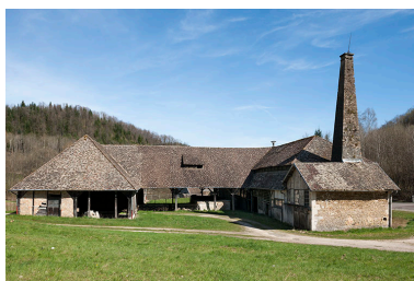
Vue rapprochée depuis l'ouest.
