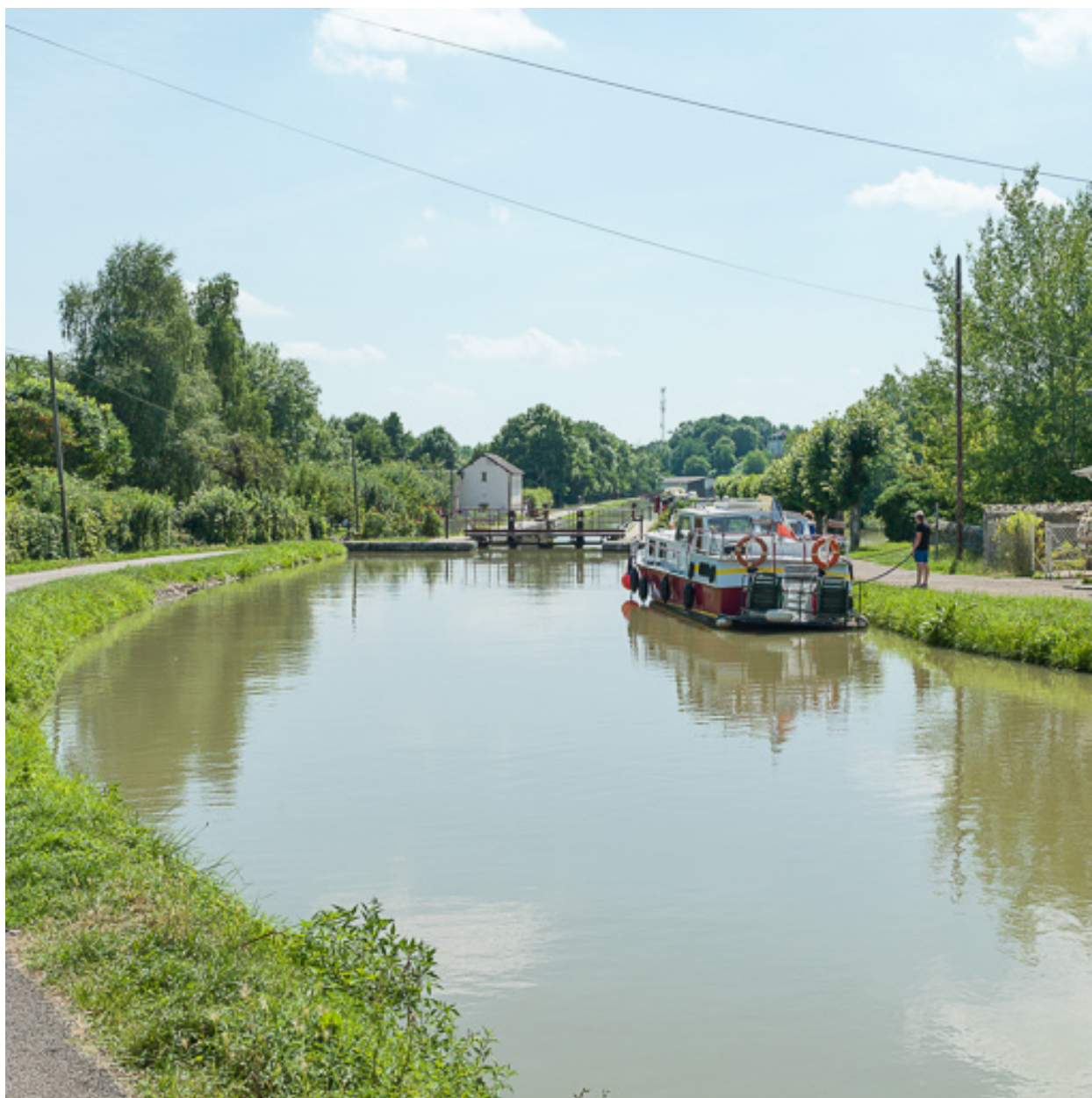
Vue du site d'écluse.
