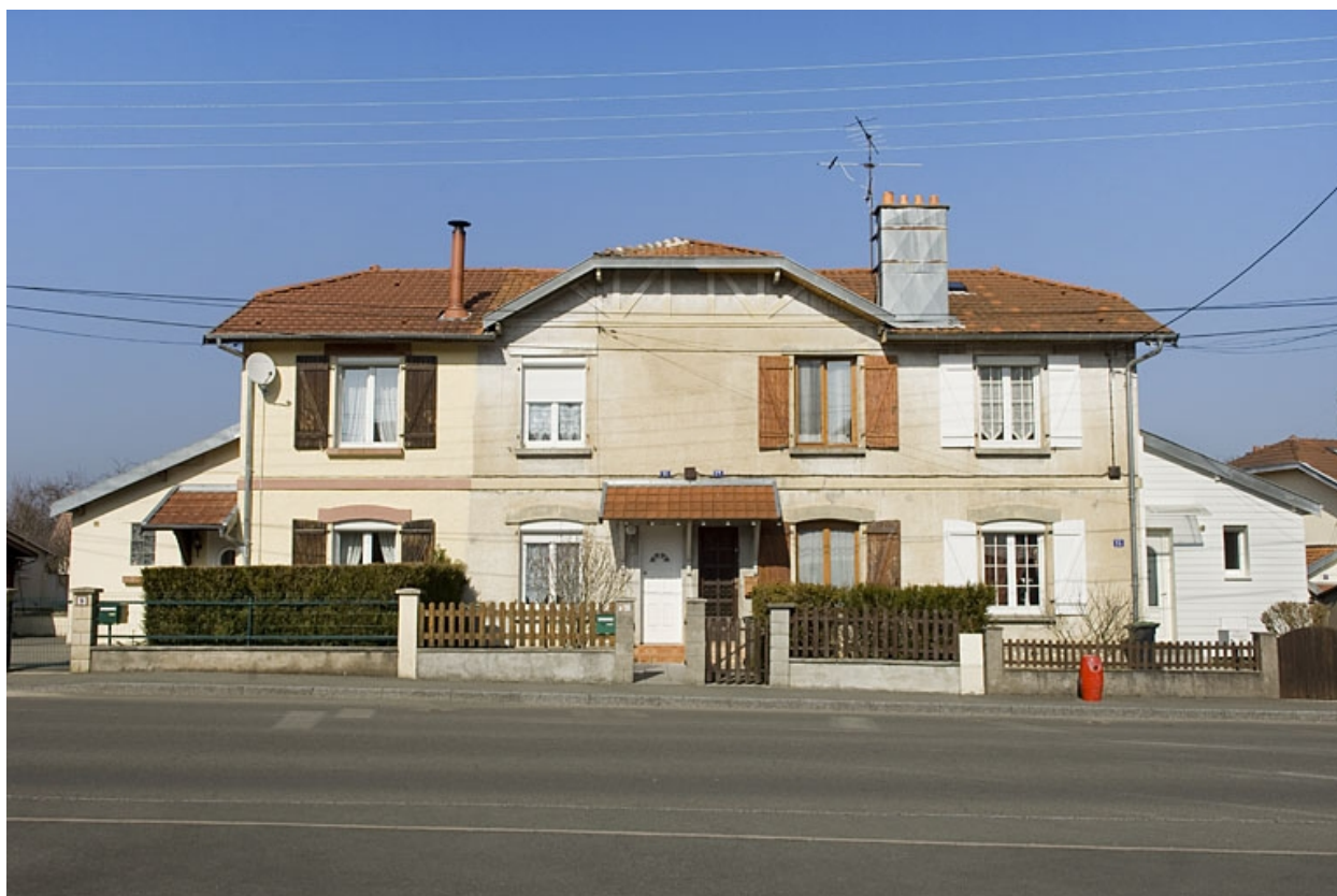
Habitation à 4 logements. Vue de face.
