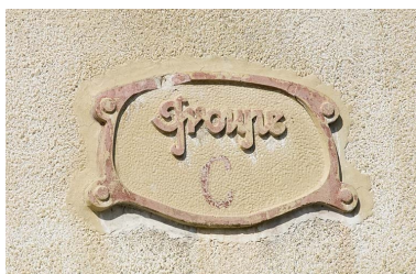
Habitation à 4 logements. Cartouche. Phot. Marc Loukachine IVR43_20122500261NUC2A
