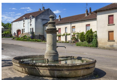
La fontaine vue depuis le nord. Phot. Jérôme Mongreville IVR43_20217000665NUC4A
