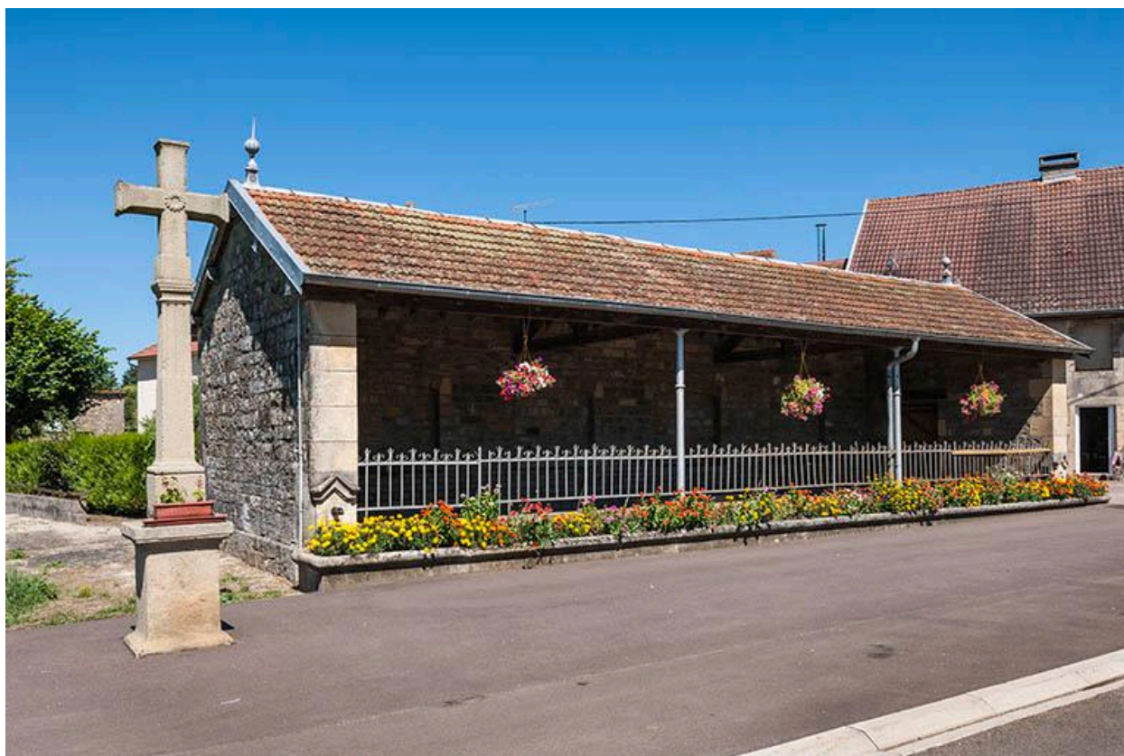
Lavoir communal construit en 1910, calvaire, le long de la route de Fouchécourt.
