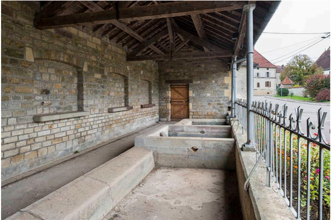
Lavoir communal, les trois bassins couverts, la galerie des laveuses.
