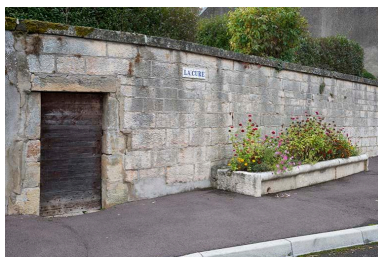
Fontaine de la Cure, le long du mur de clôture du presbytère. Phot. Jérôme Mongreville IVR43_20167001470NUC4A
