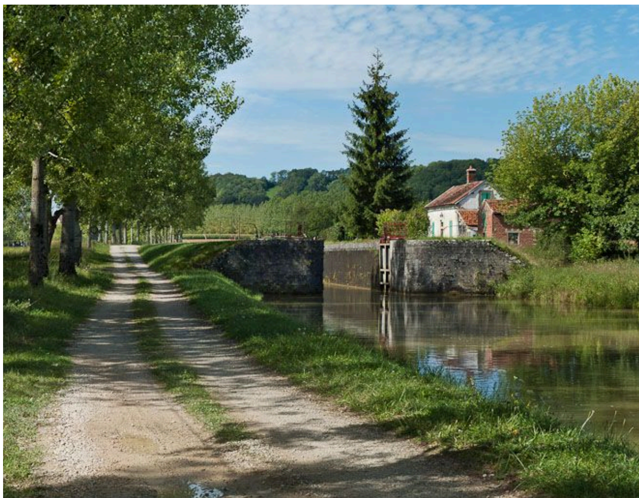
Vue du site d'écluse depuis l'aval.
