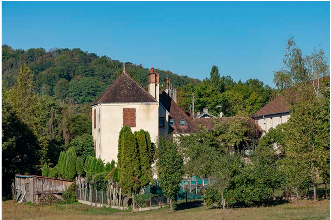
Vue prise depuis le chemin des Vignes.
