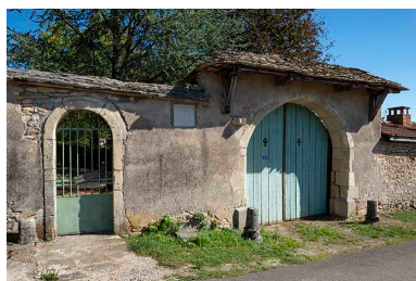
Le portail d'entrée. Phot. Jérôme Mongreville IVR43_20187000675NUC4A
